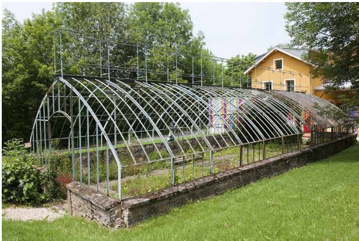
Serre et communs depuis le sud-est.
