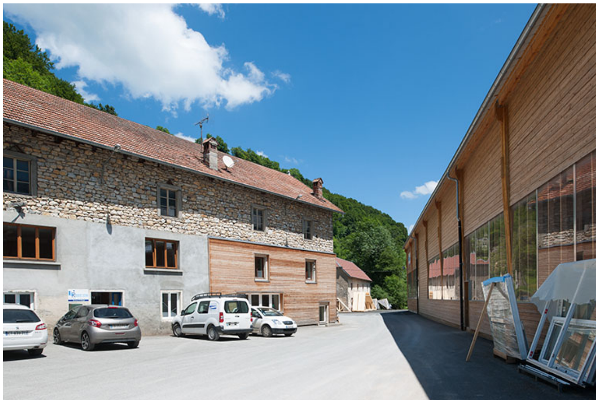
Bâtiment du moulin (à gauche) et de l'entreprise de charpente (à droite). 25, Feule, lieudit : la Barbèche
