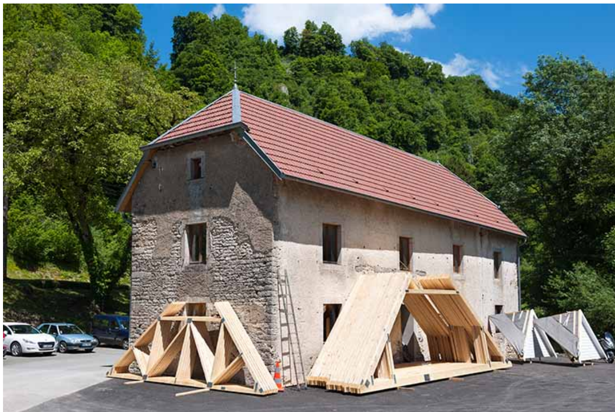
Bâtiment agricole depuis le sud-ouest.
