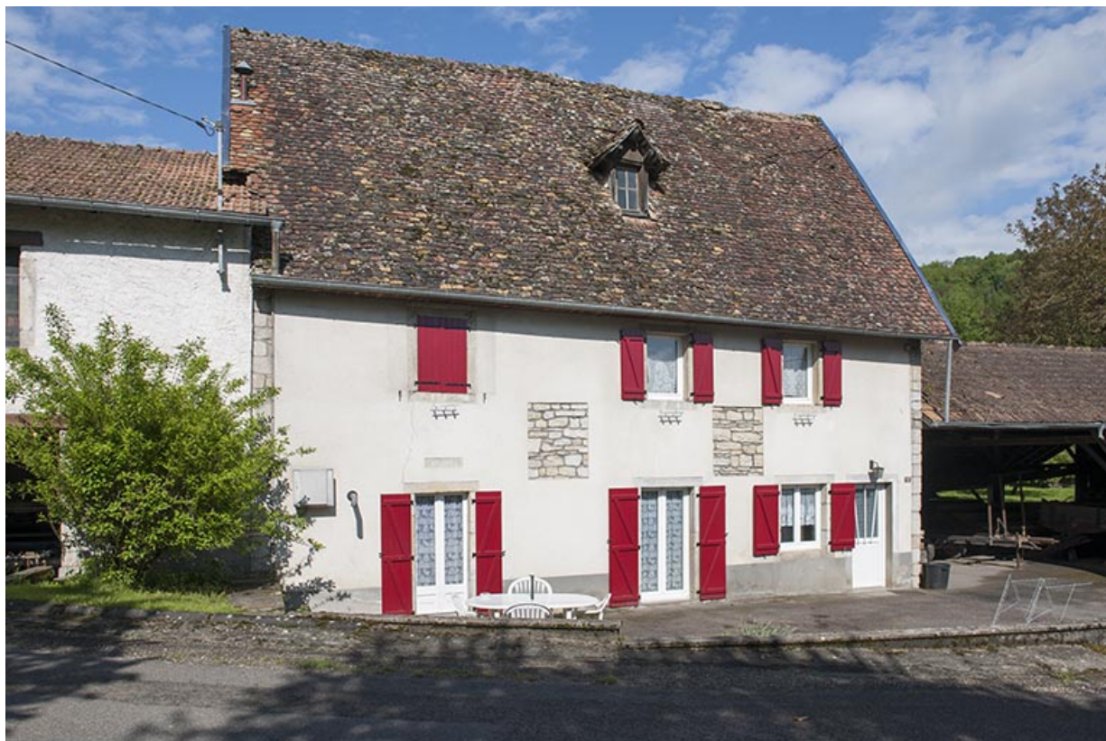
Façade est du moulin.
