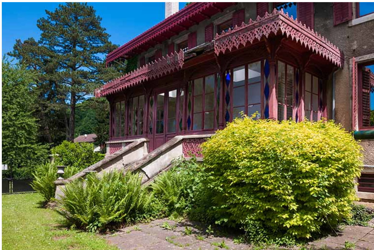
Véranda sur la façade ouest.
