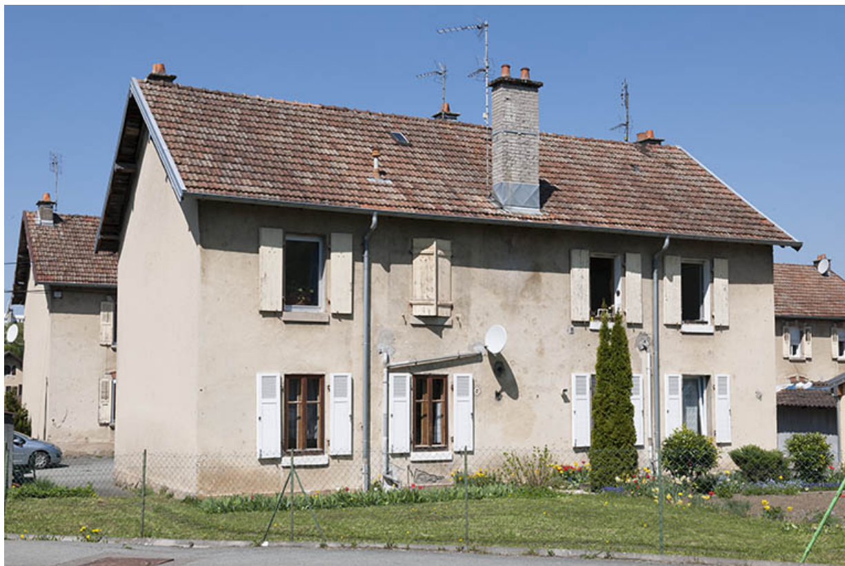
Façade postérieure d'une habitation.
