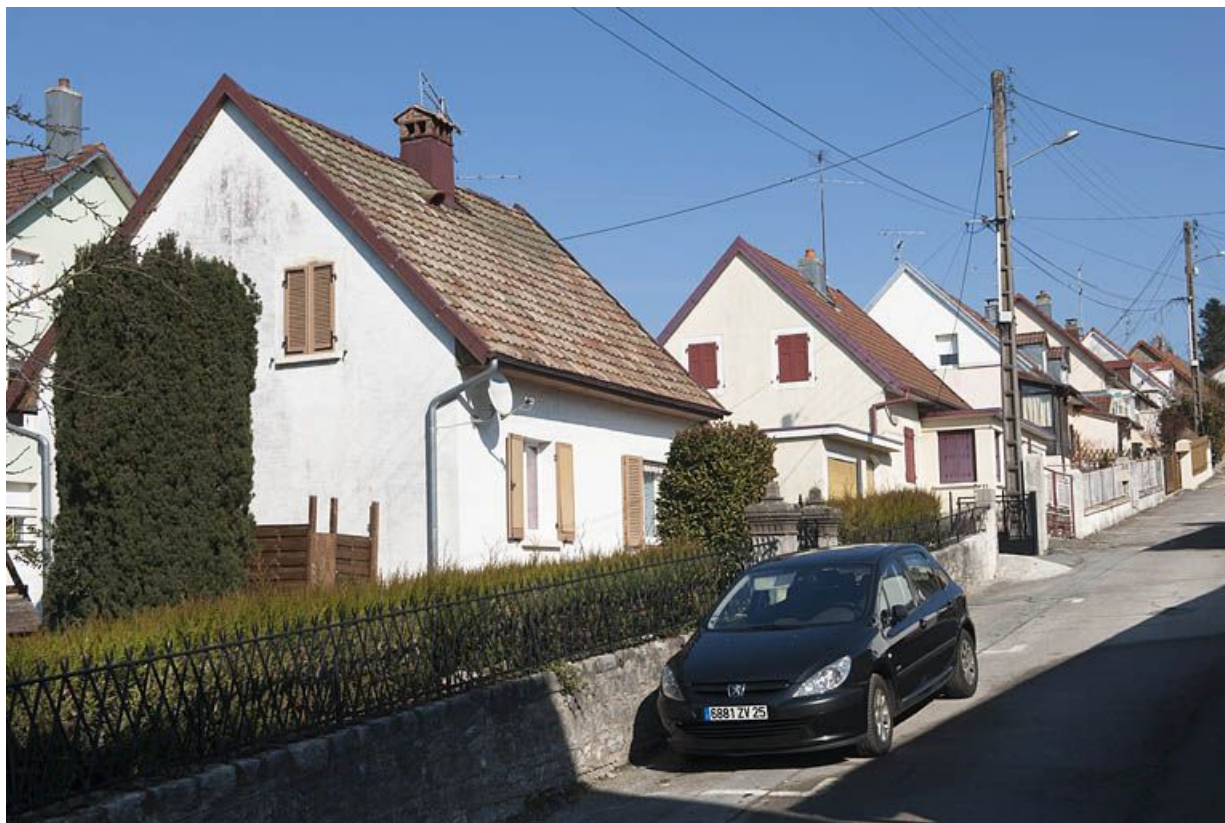
Rue de Belfort. Maisons côté impair.
