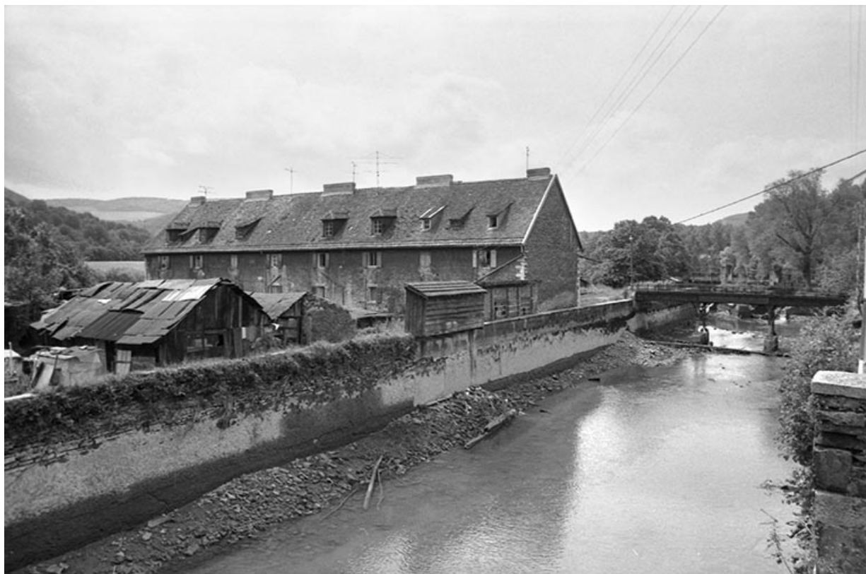
Logement d'ouvriers situé sur l'île. Vue de trois quarts arrière depuis l'aval en 1980.
