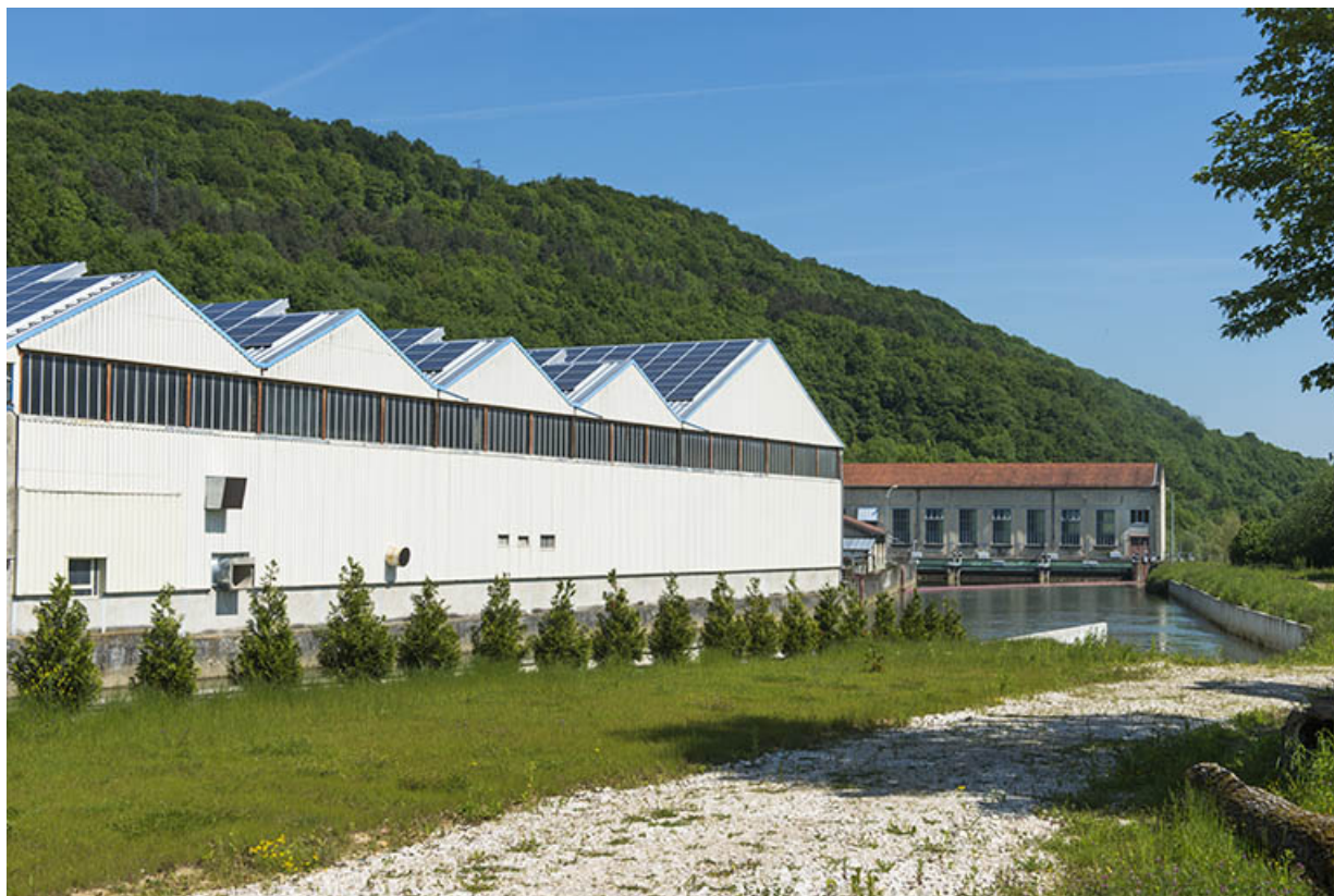
Façade est de l'atelier de laminage et centrale hydroélectrique.
