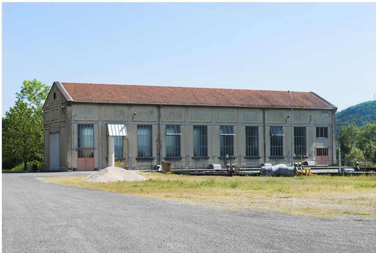
Façade sud de la centrale hydroélectrique.
