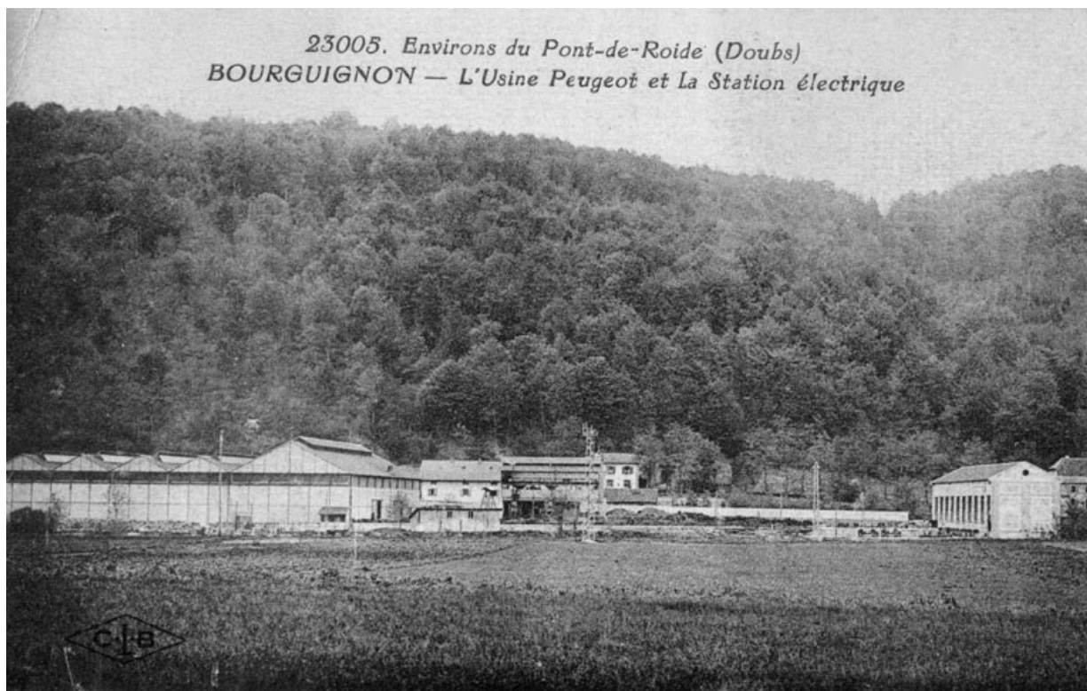
Environs du Pont-de-Roide. Bourguignon. L'usine Peugeot et la station électrique. 25, Bourguignon, lieudit : les Forges
