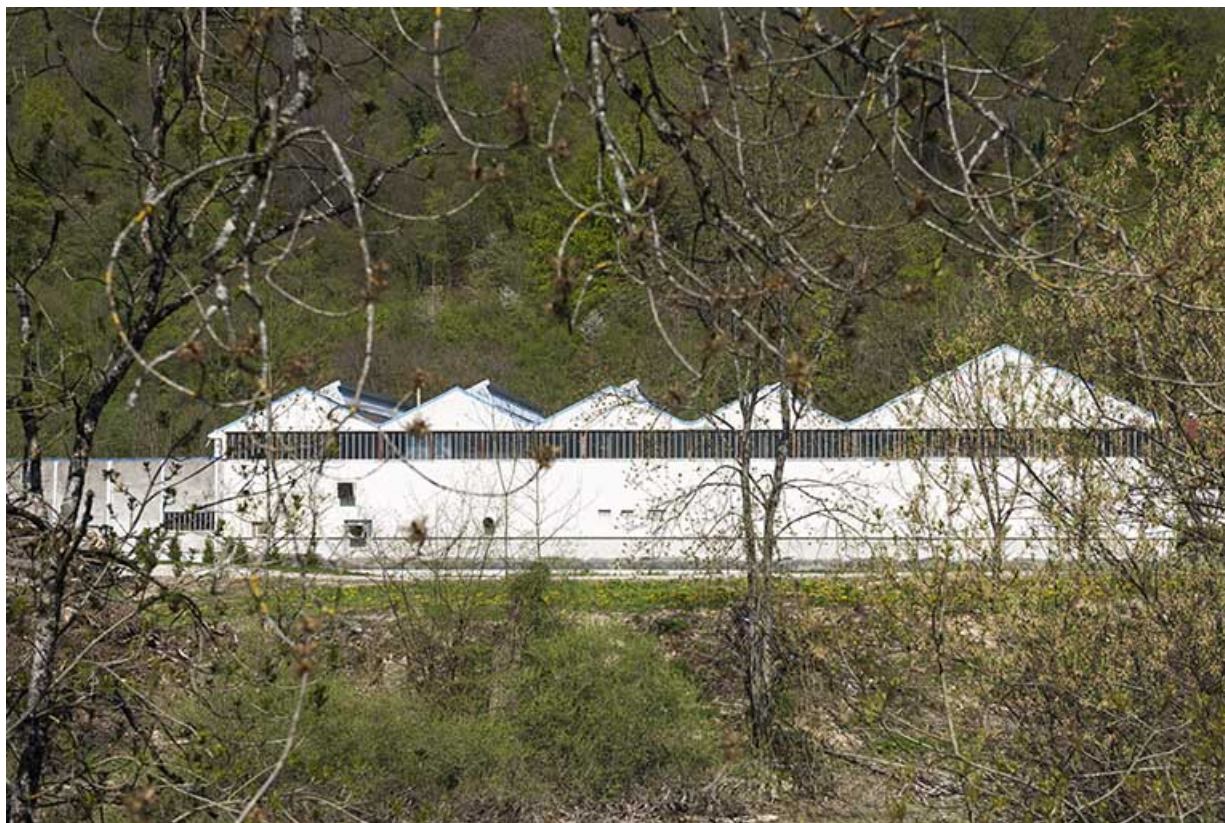
Façade est de l'atelier de laminage.
