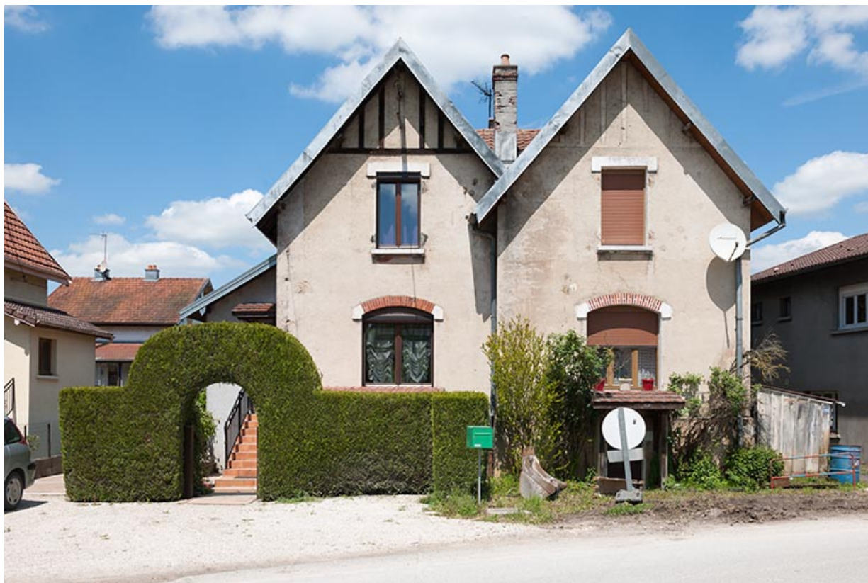
Façade antérieure d'une maison jumelée. 25, Colombier-Fontaine rue des Cités
