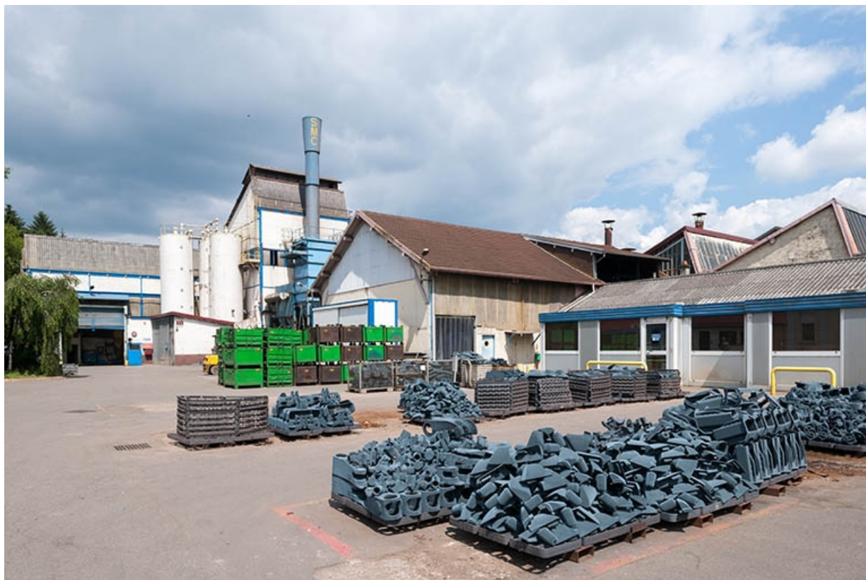
Vue de la cour depuis le sud-ouest.
