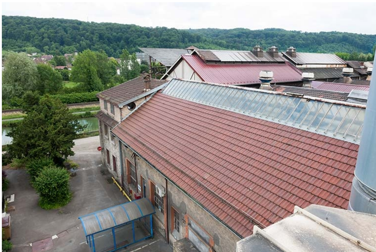
Vue plongeante sur l'ancien atelier de noyautage.
