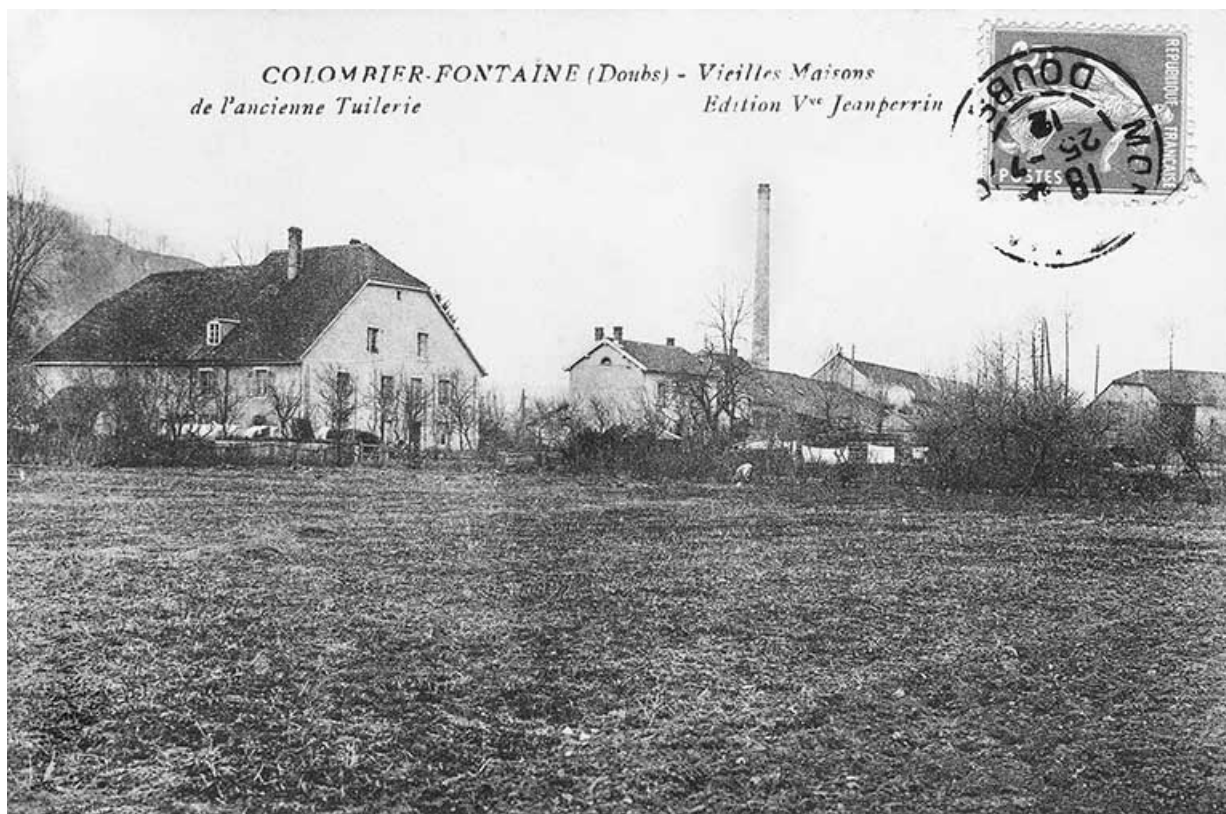
Colombier-Fontaine (Doubs). Vieilles maisons de l'ancienne tuilerie.
