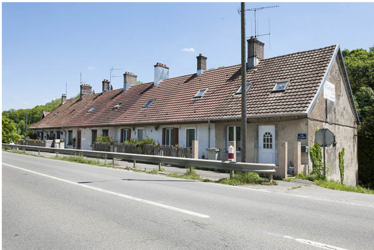
Habitation de type caserne (commune de Colombier-Fontaine). 25, Étouvans, lieudit : la Raydans
