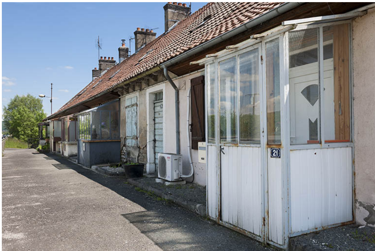
Habitation de type caserne. Entrée sur la façade nord.
