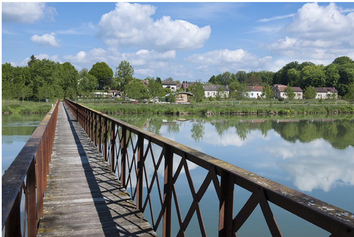
La cité ouvrière de Lougres depuis la passerelle sur le Doubs. 25, Colombier-Fontaine rue de la Filature, lieudit : la Champagnole
