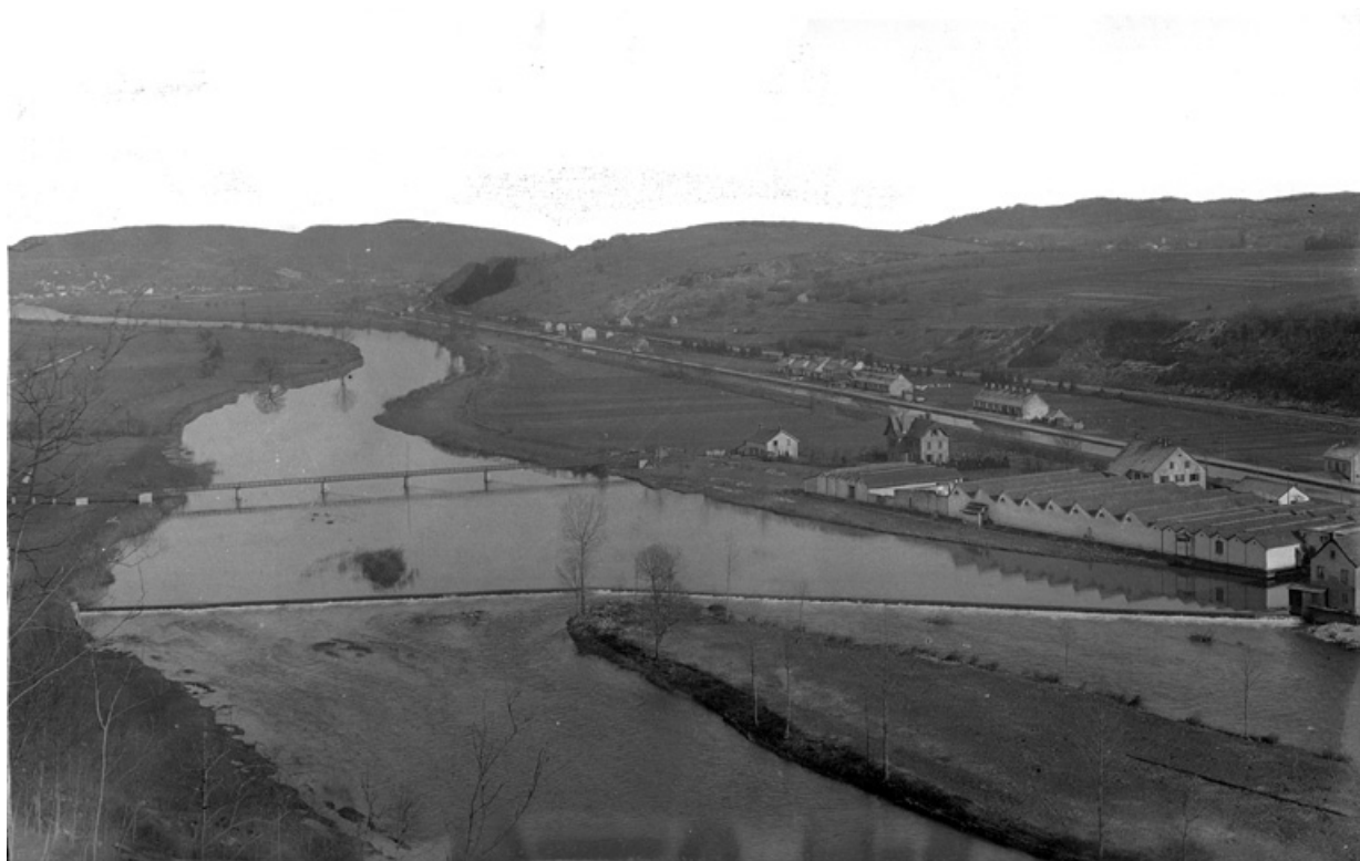
Vue plongeante depuis l'ouest. La passerelle, les cités ouvrières et la partie nord de l'usine. Photogr. Mayer, s.d. [vers 1930]. 25, Colombier-Fontaine rue de la Filature, lieudit : la Champagnole
