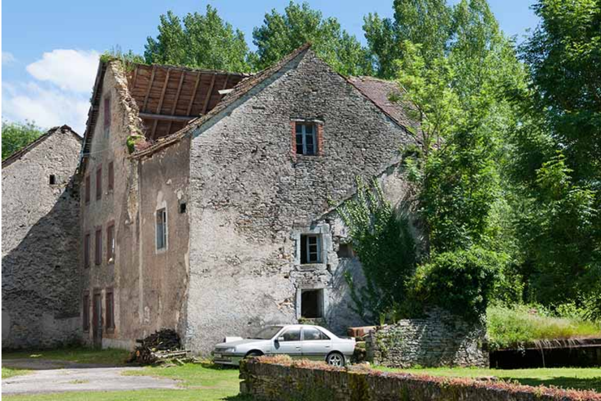
Le moulin depuis le nord-ouest.
