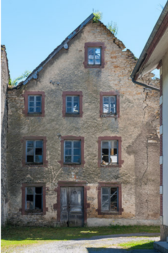
Pignon nord du moulin.
