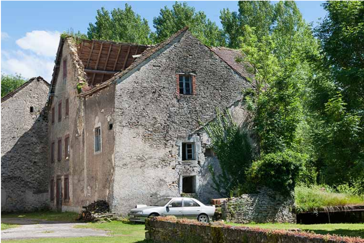
Le moulin depuis le nord-ouest.
