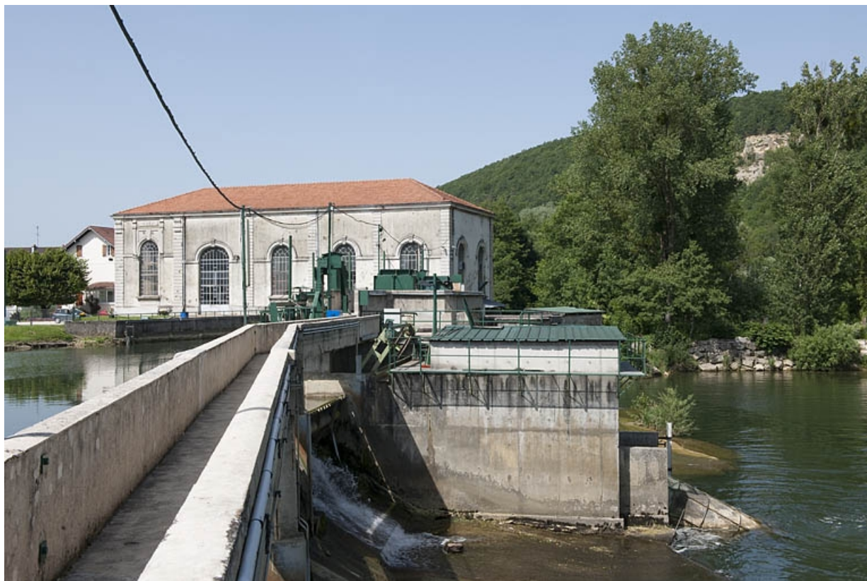
Extrémité nord du barrage et façade sud de la centrale.
