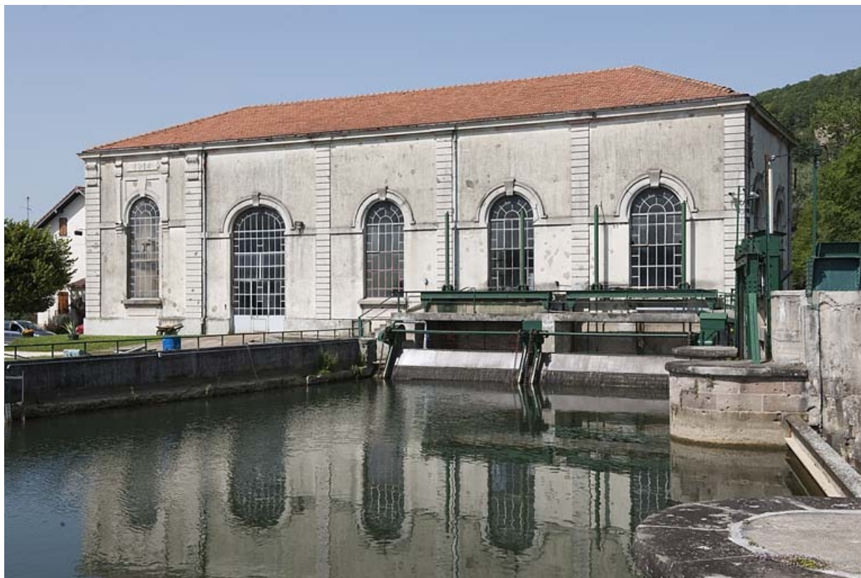
Façade sud de la centrale et prises d'eau.
