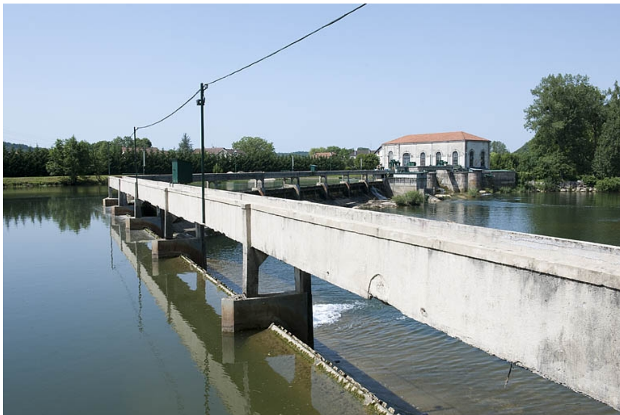
Vue éloignée depuis l'amont du barrage.
