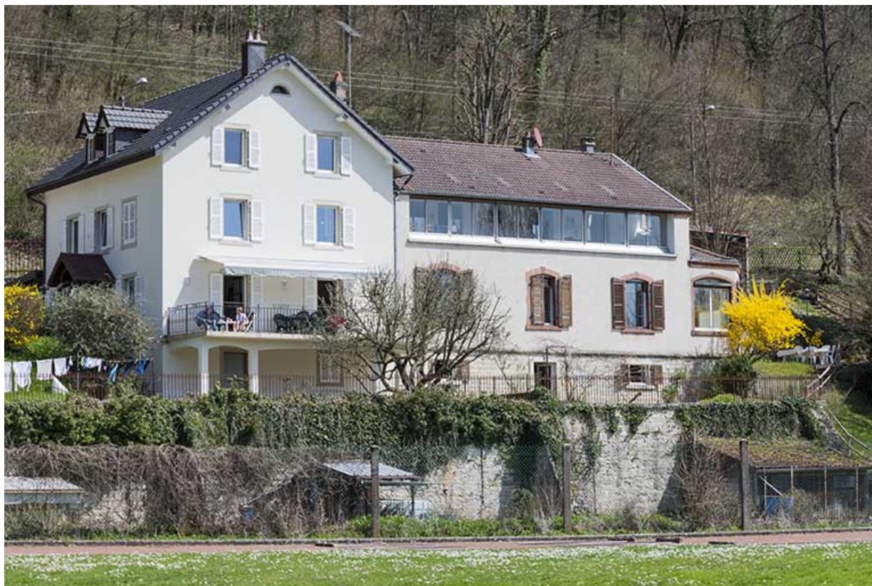
Façade ouest vue de trois quarts gauche.
