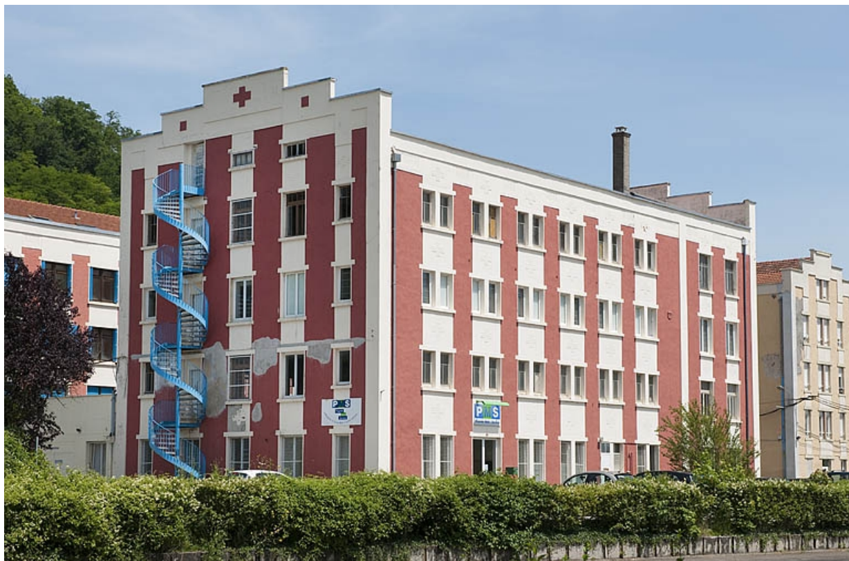
Immeuble de dortoirs (sud). Vue de trois quarts.
