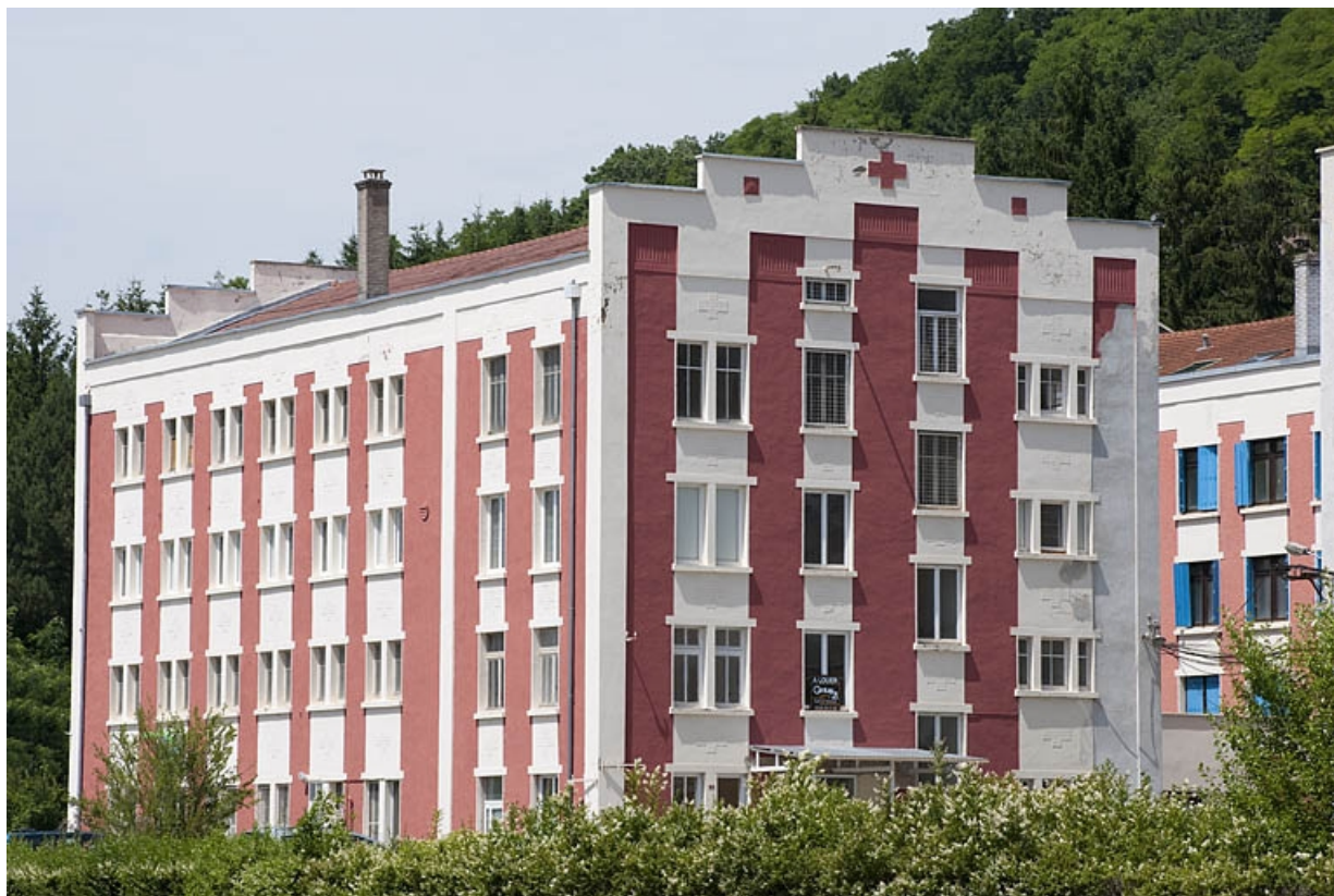
Immeuble de dortoirs (sud). Vue depuis le sud-est. 25, Sochaux rue sous la Côte
