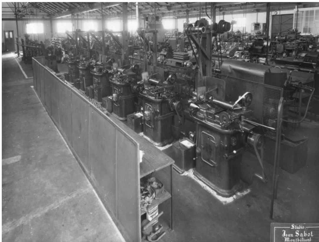
Vue intérieure de l'atelier. Batterie de machines (à décolleter ?).
