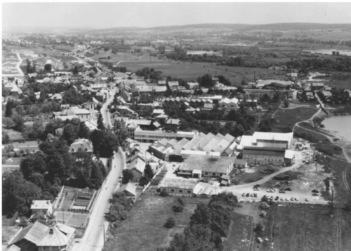
Vue aérienne de l'usine depuis le sud. 25, Vieux-Charmont, 10 route de Belfort
