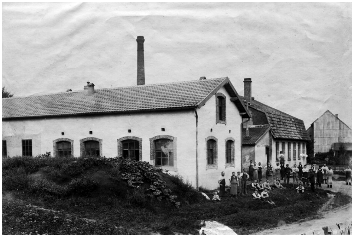
[Usine Ferrand à Grand-Charmont].
