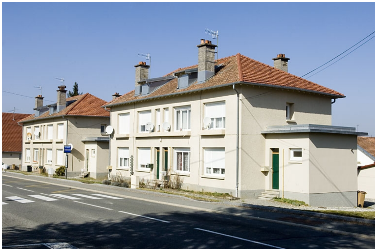
Ensemble d'habitations des années 1950. Vue depuis le sud. 25, Vieux-Charmont rue du Crepon
