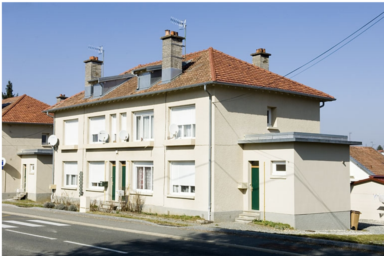
Habitation des années 1950. Vue de trois quarts droite. 25, Vieux-Charmont rue du Crepon
