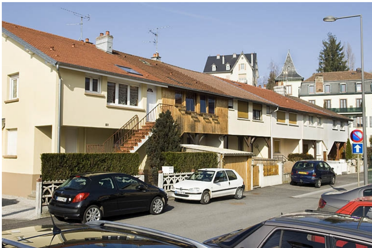
Façade sur la rue de Mulhouse. 25, Montbéliard rue de Mulhouse
