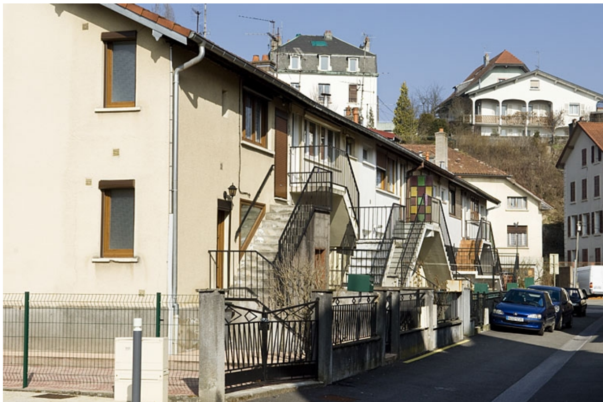
Habitation ouvrière rue de Guebwiller. Façade antérieure vue de trois quarts. 25, Montbéliard rue de Mulhouse
