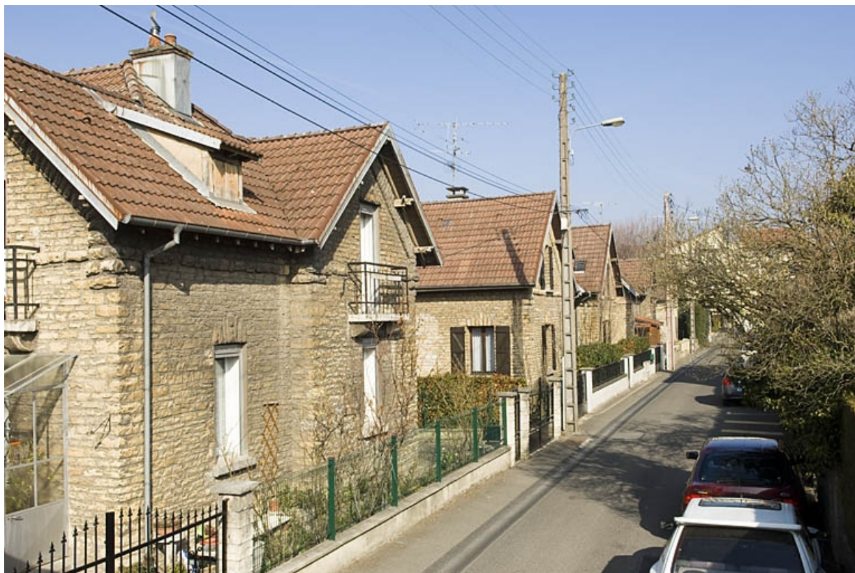
Façades antérieures sur la rue des Fleurs.
