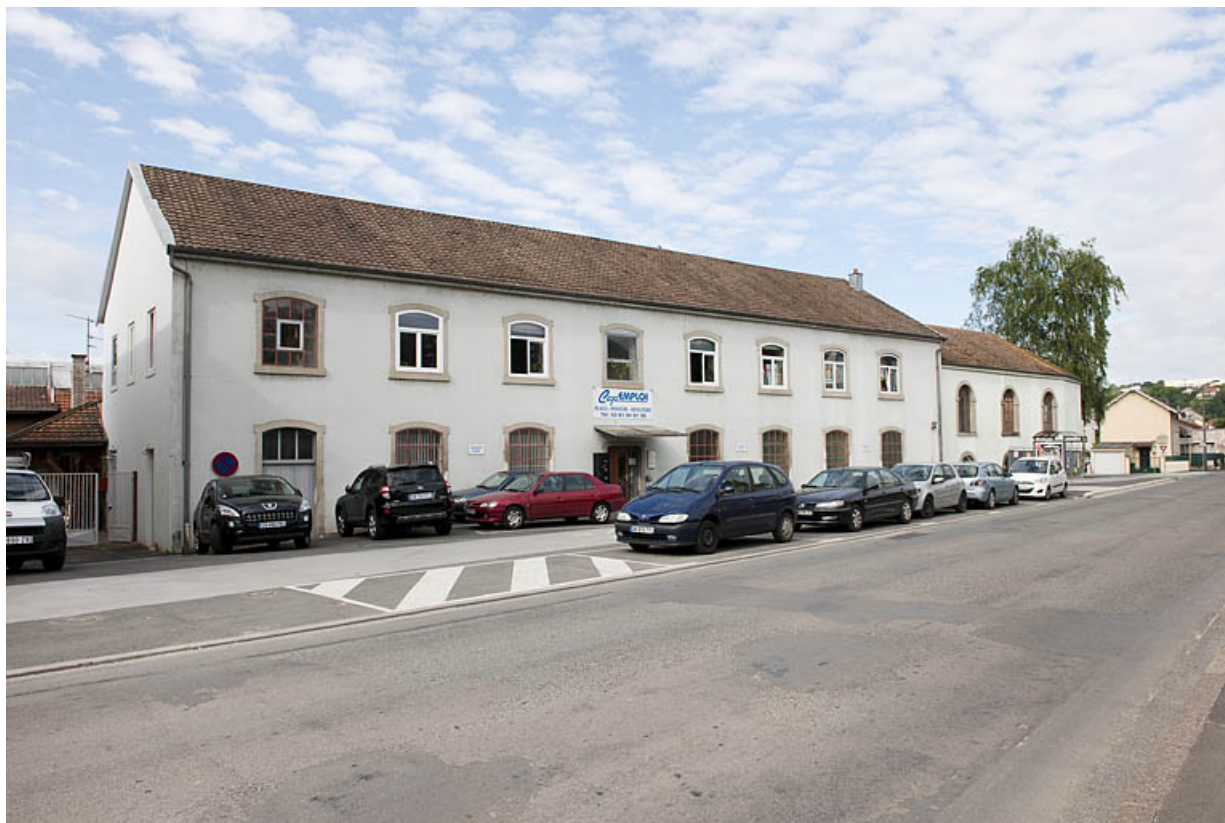
Bâtiment administratif (?) longeant le faubourg de Besançon.
