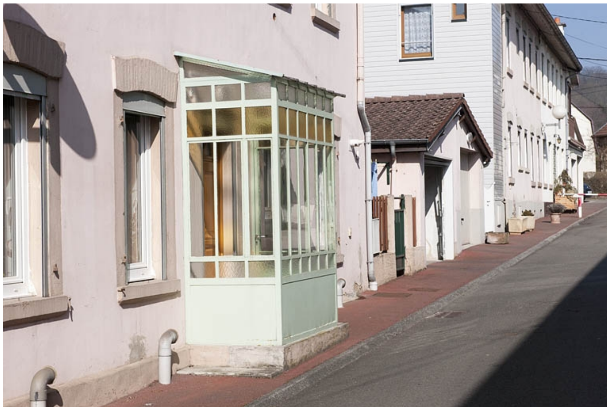
Façade sur rue d'une habitation à 8 logements. 25, Sainte-Suzanne rue des Lilas
