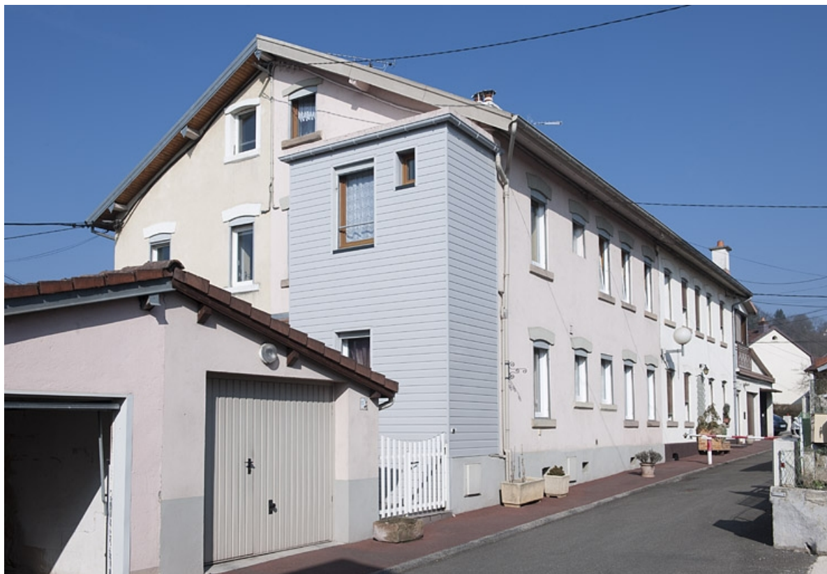
Habitation à 8 logements. Façade sur la rue des Campenottes. 25, Sainte-Suzanne rue des Lilas
