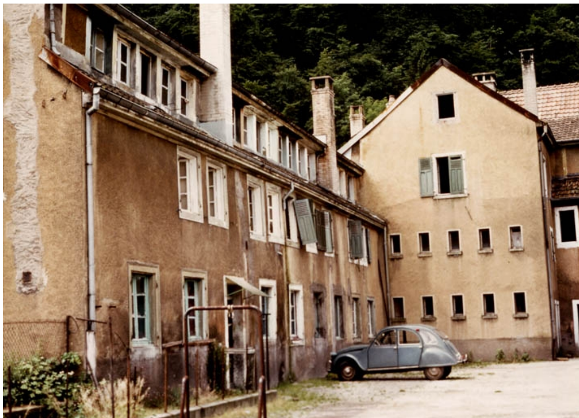
Façade sur cour de l'aile sud.
