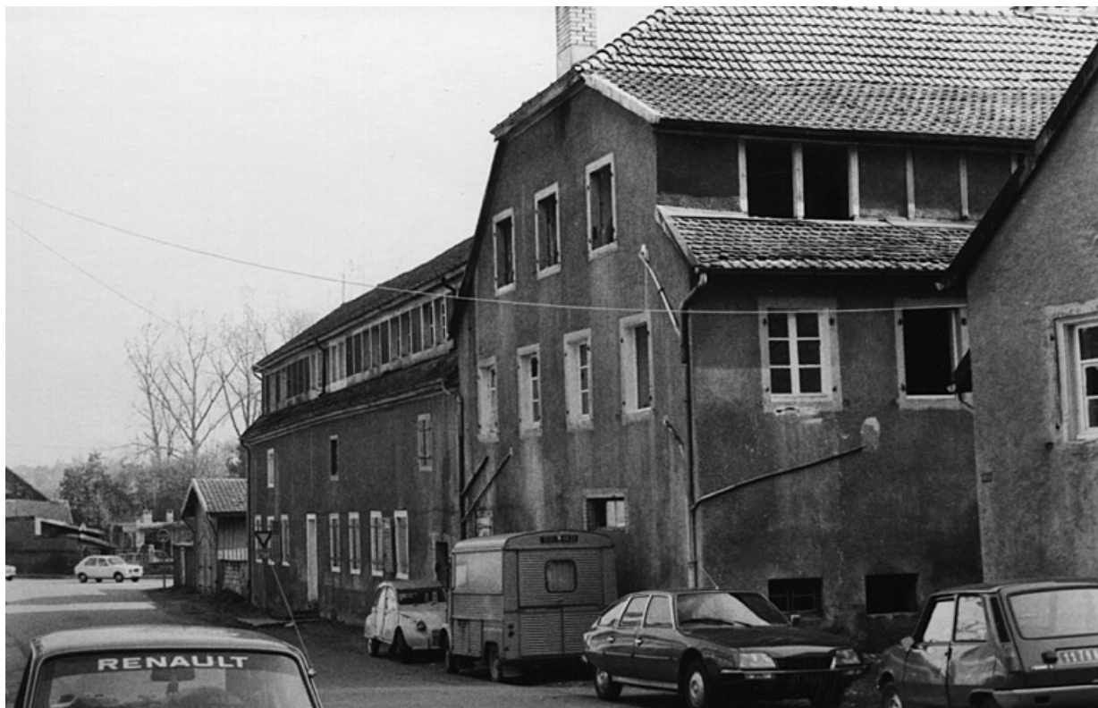
Vue des bâtiments depuis l'ouest.
