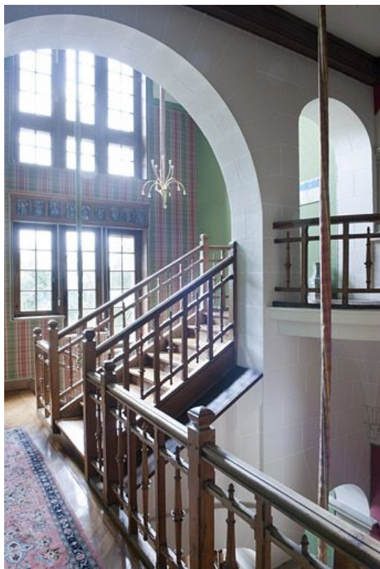
Cage d'escalier ajouré depuis l'entresol.
