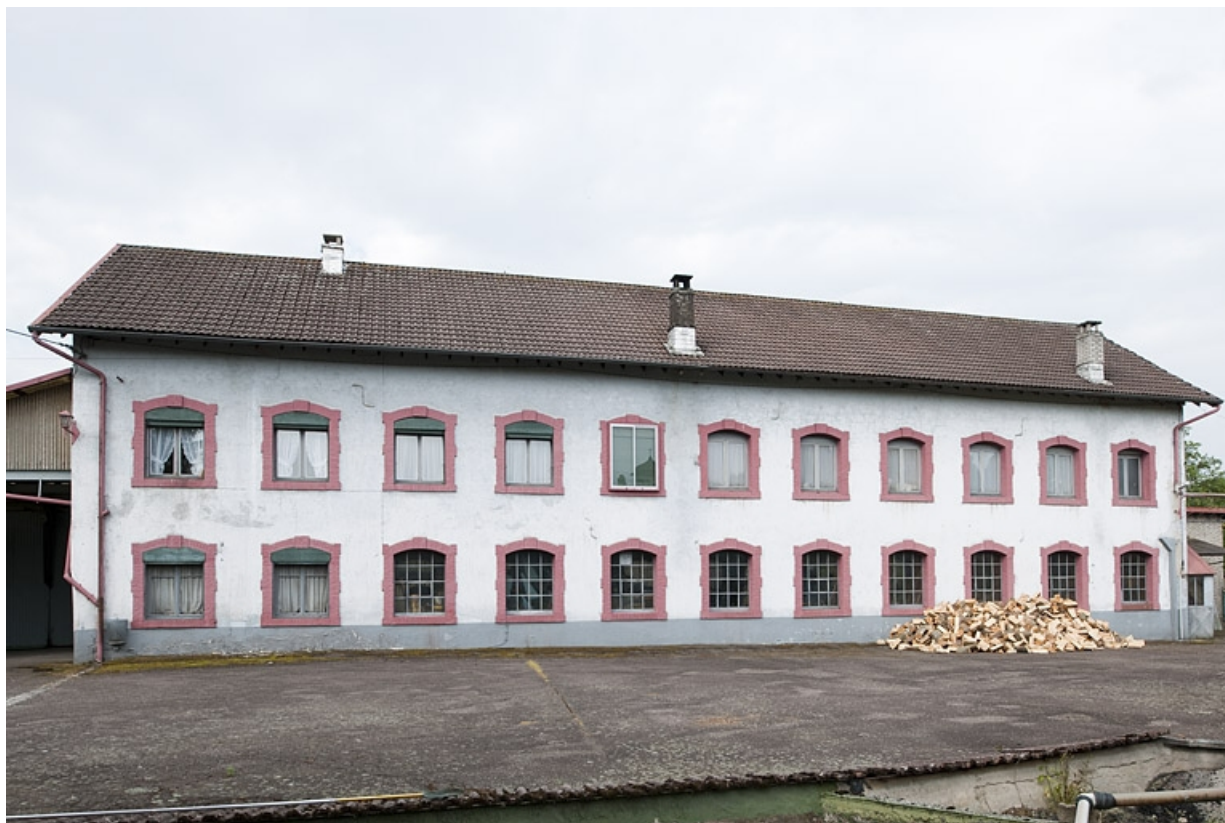
Atelier de fabrication. Façade antérieure.
