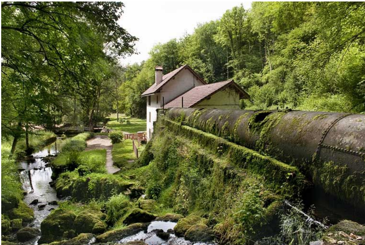
La conduite d'amenée couvert et le moulin vus depuis la source.
