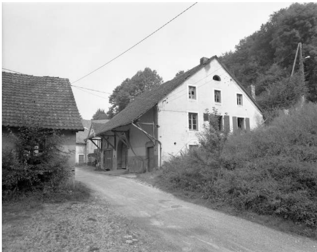
Bâtiment agricole en 1981.
