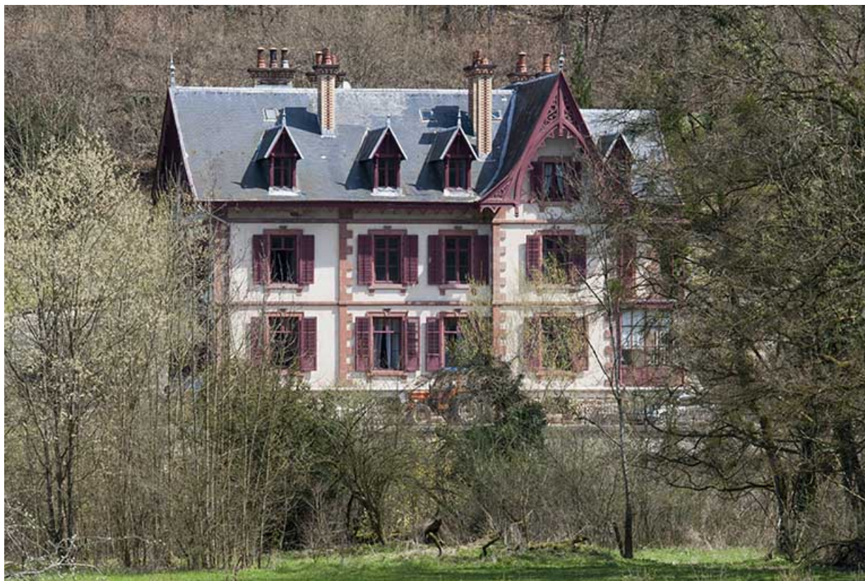
Façade antérieure du logement patronal Sircoulon.
