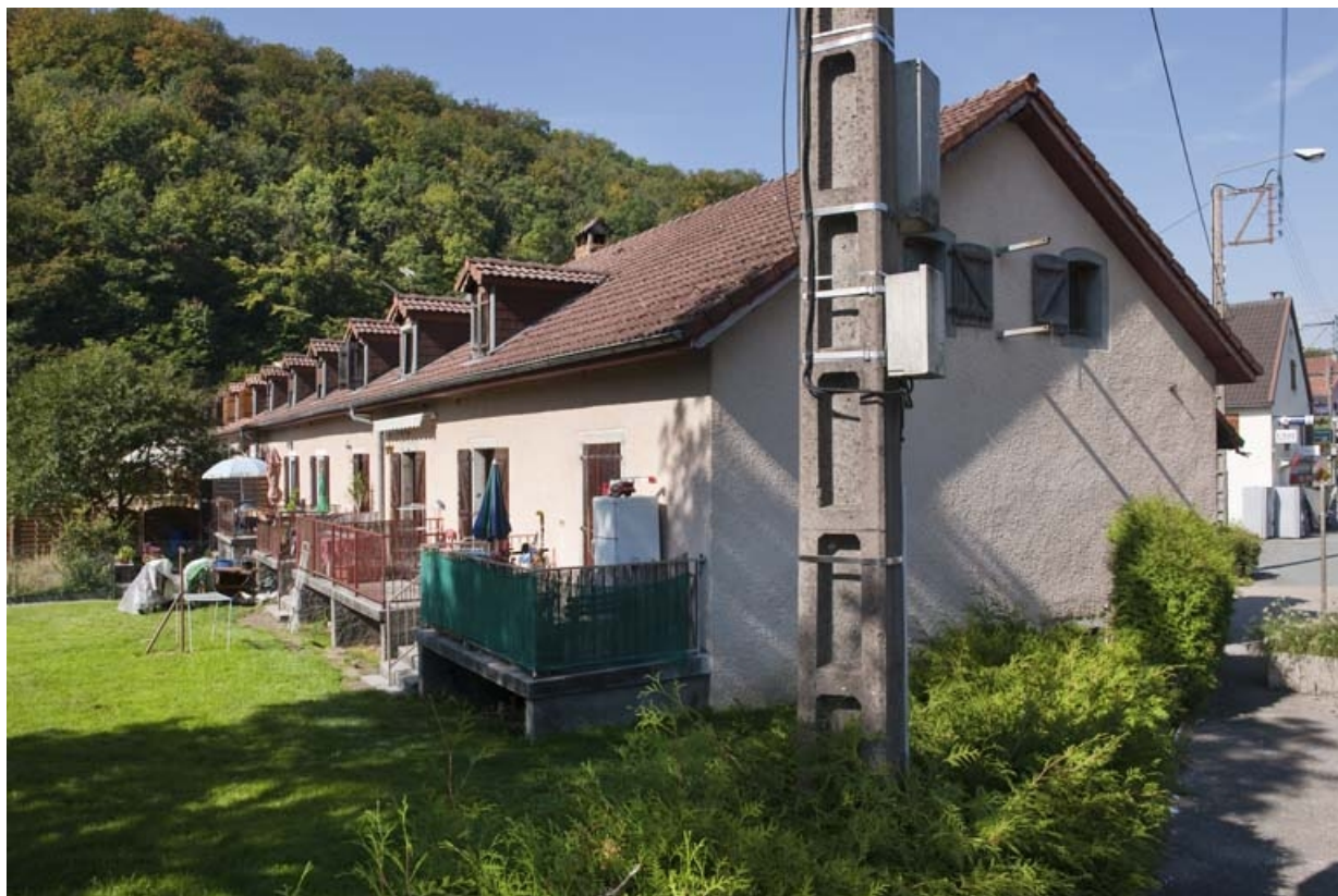
Caserne G. Façade postérieure vue depuis l'est. 25, Hérimoncourt rue Adèle Prud'hon
