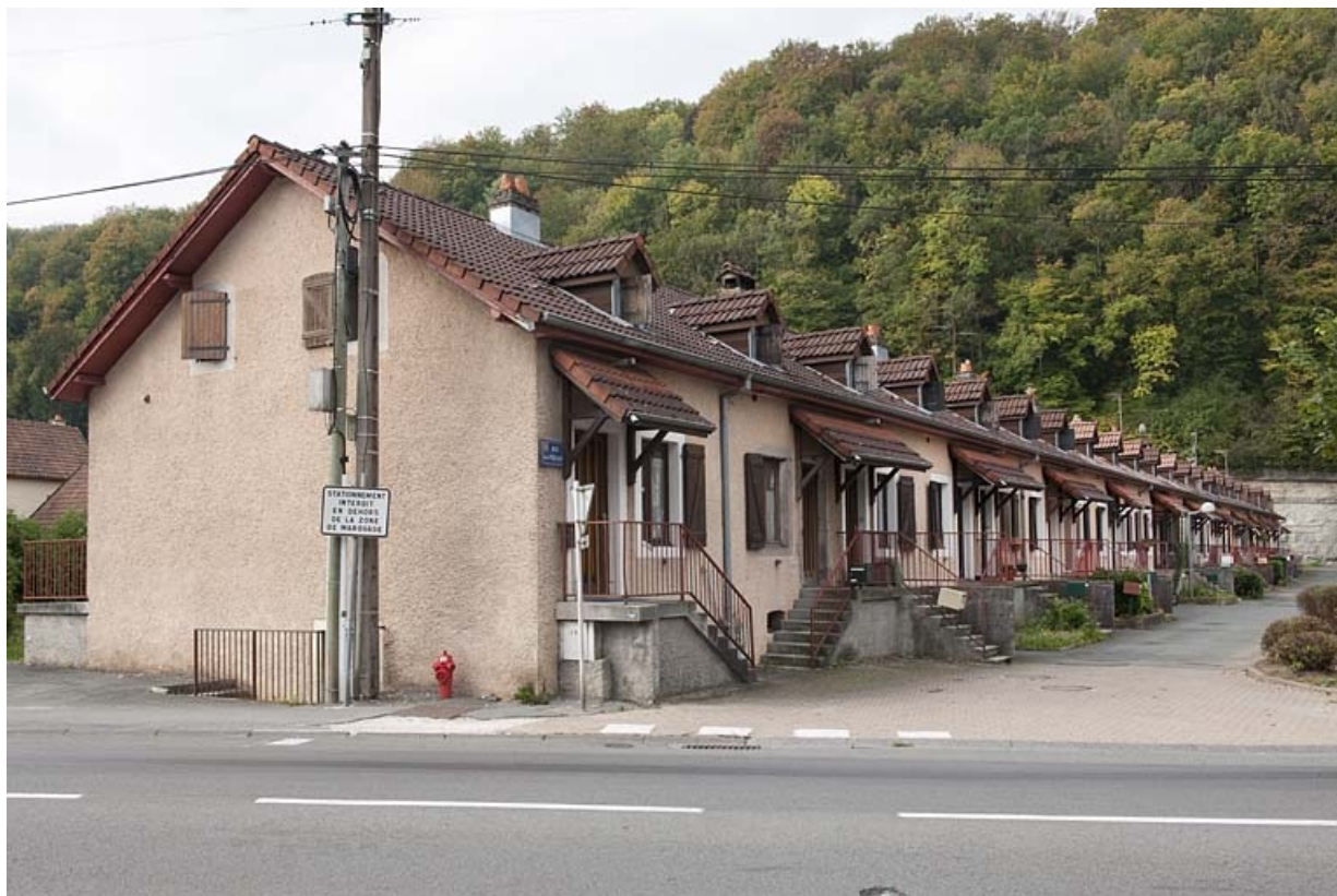
Caserne F. Vue depuis la route départementale. 25, Hérimoncourt rue Adèle Prud'hon
