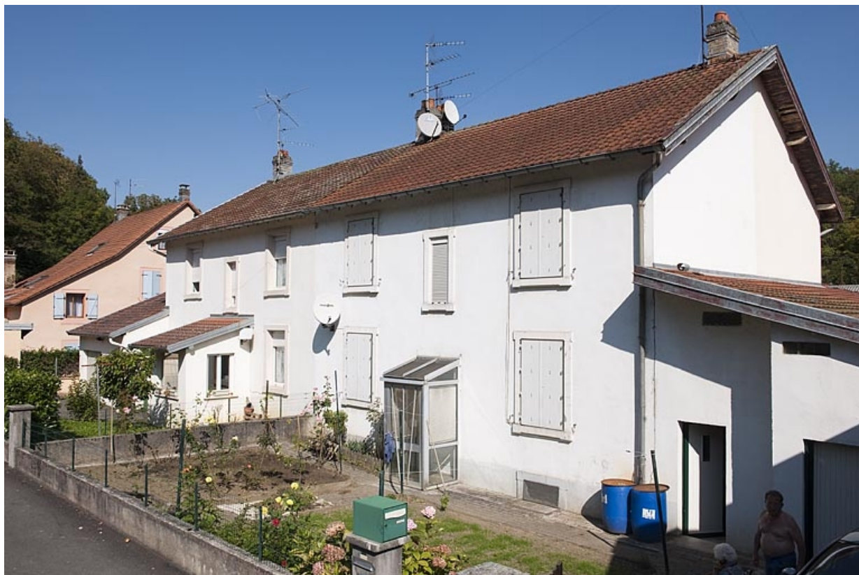
Habitation à quatre logements vue de trois quarts.
