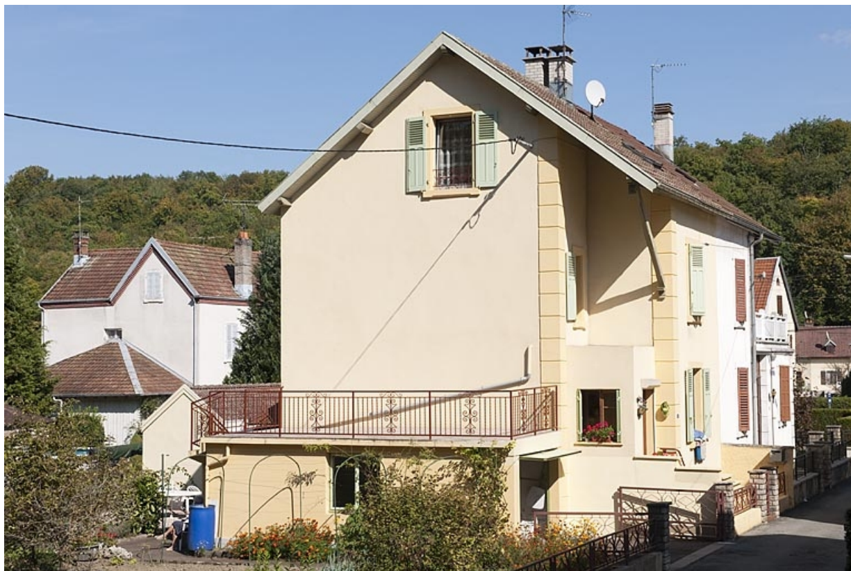
Maison jumelée (de cadres ?). Vue de trois quarts.
