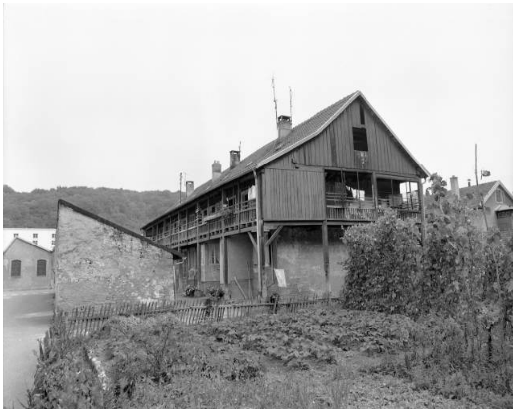
Vue de trois quarts depuis le nord-ouest en 1981.
