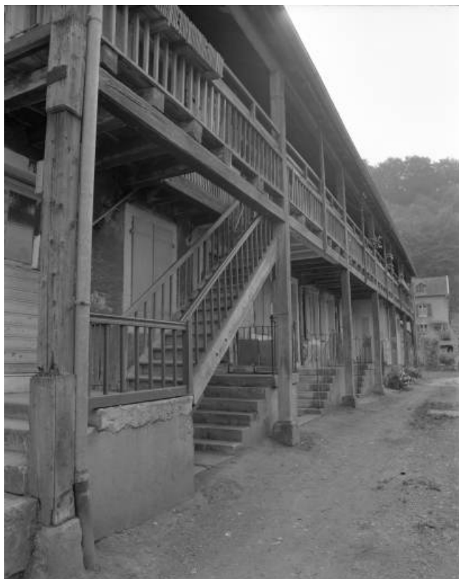
Escalier et galerie sur la façade nord en 1981.
