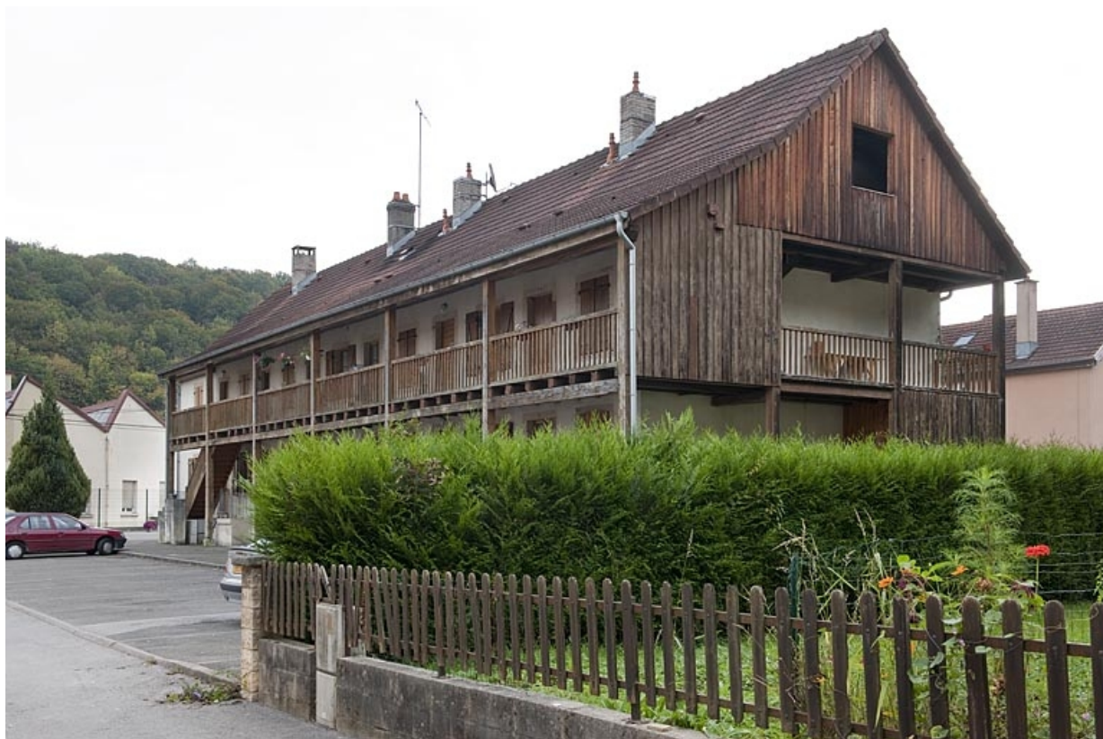
Vue de trois quarts depuis l'ouest.
