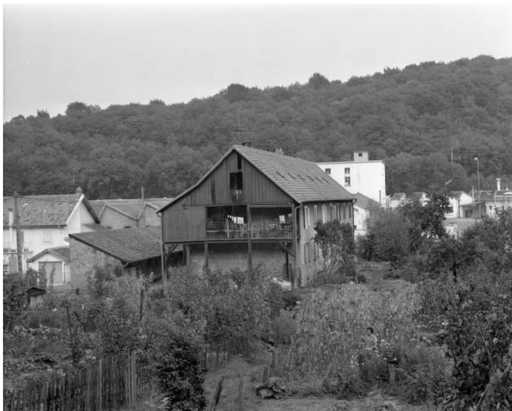
Vue d'ensemble depuis l'ouest en 1981. 25, Hérimoncourt, 3 à 13 rue de la Bastille
