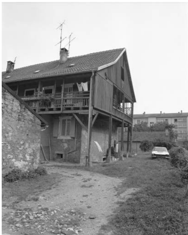
Pignon ouest en 1981.
