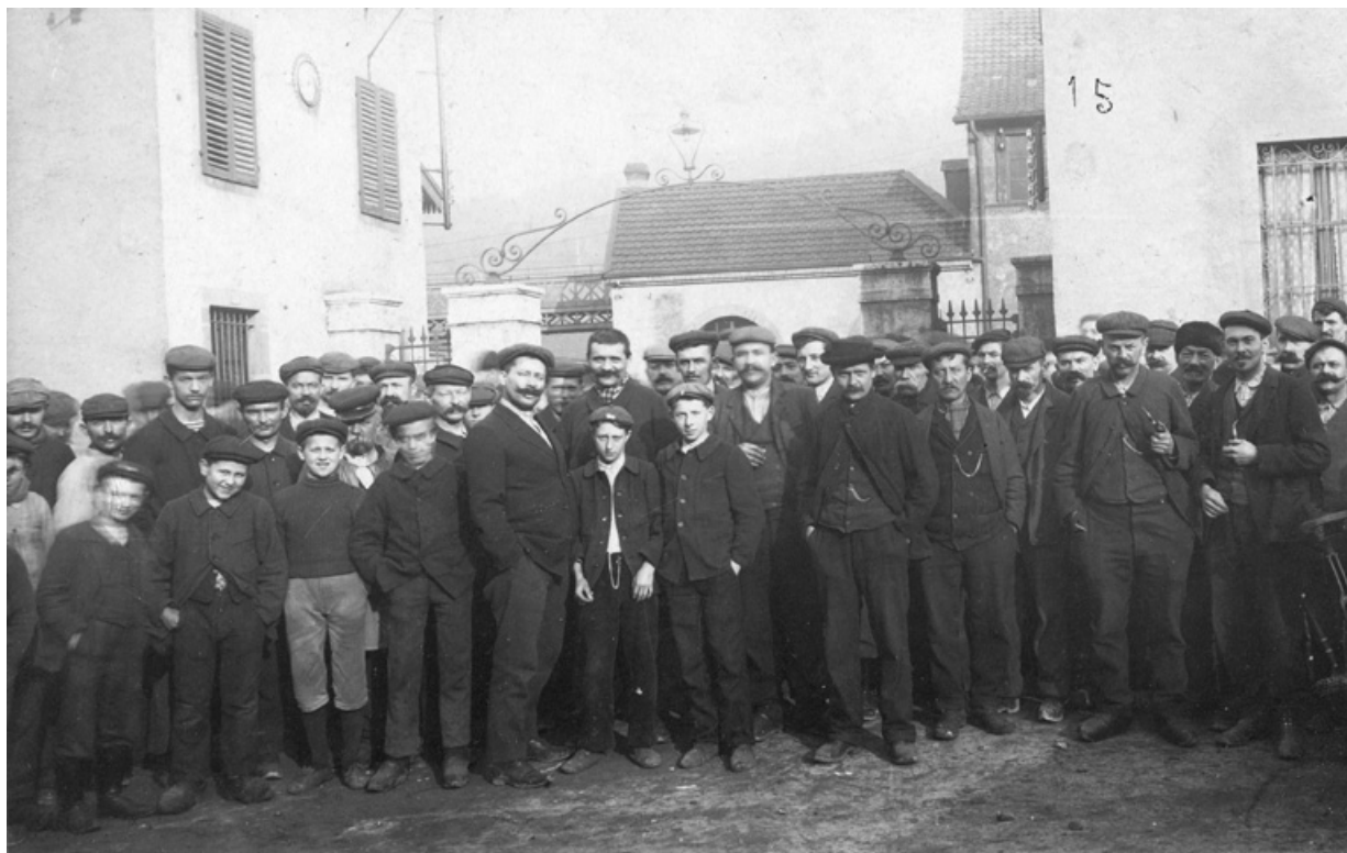
Groupe d'ouvriers à la portière centrale de l'usine.
