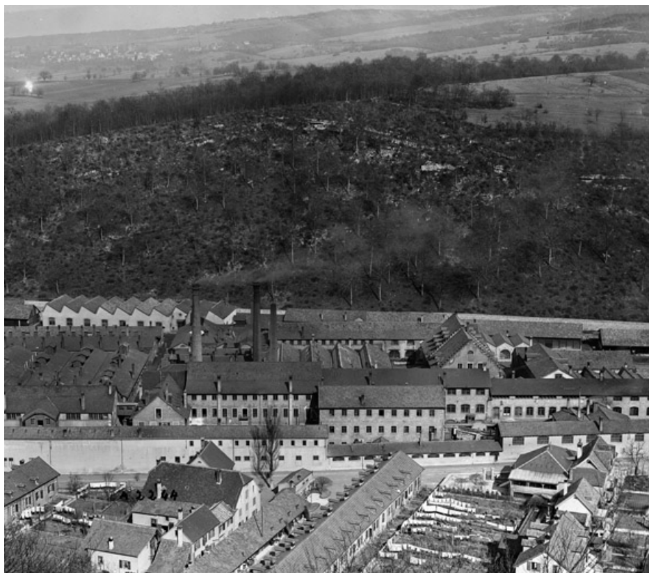
Vue plongeante partielle depuis l'ouest.
