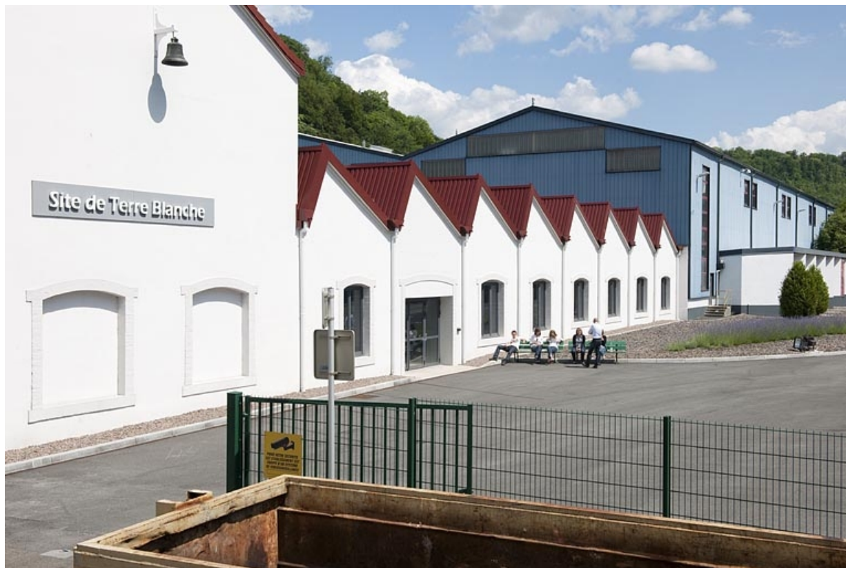
Bâtiment de bureaux (?) et centre d'archives. Façades ouest.
