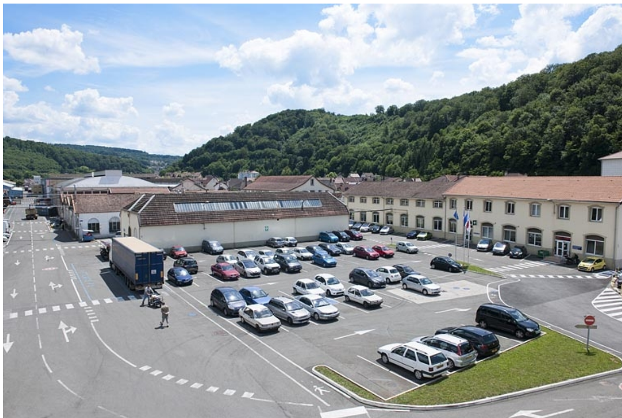
Vue plongeante du site depuis le nord.
