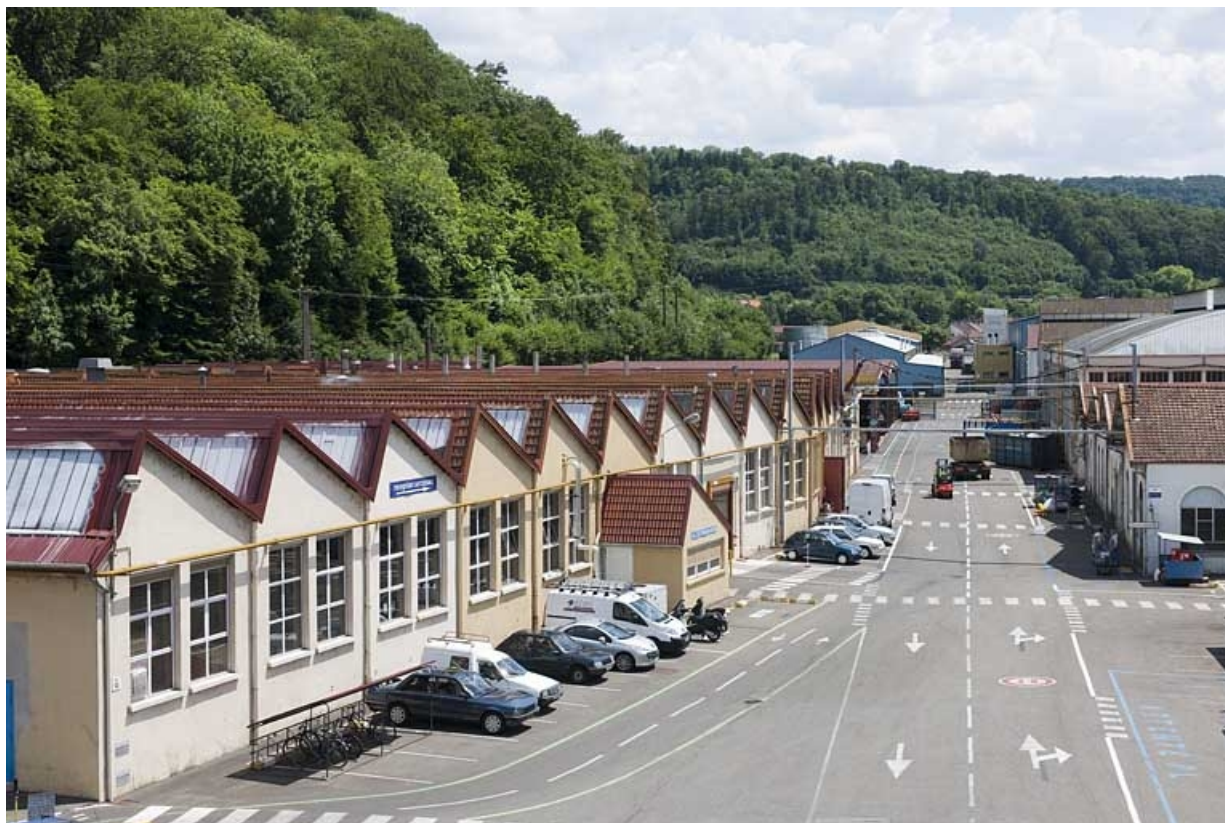
Pignons ouest de l'atelier de rénovation des moteurs.
