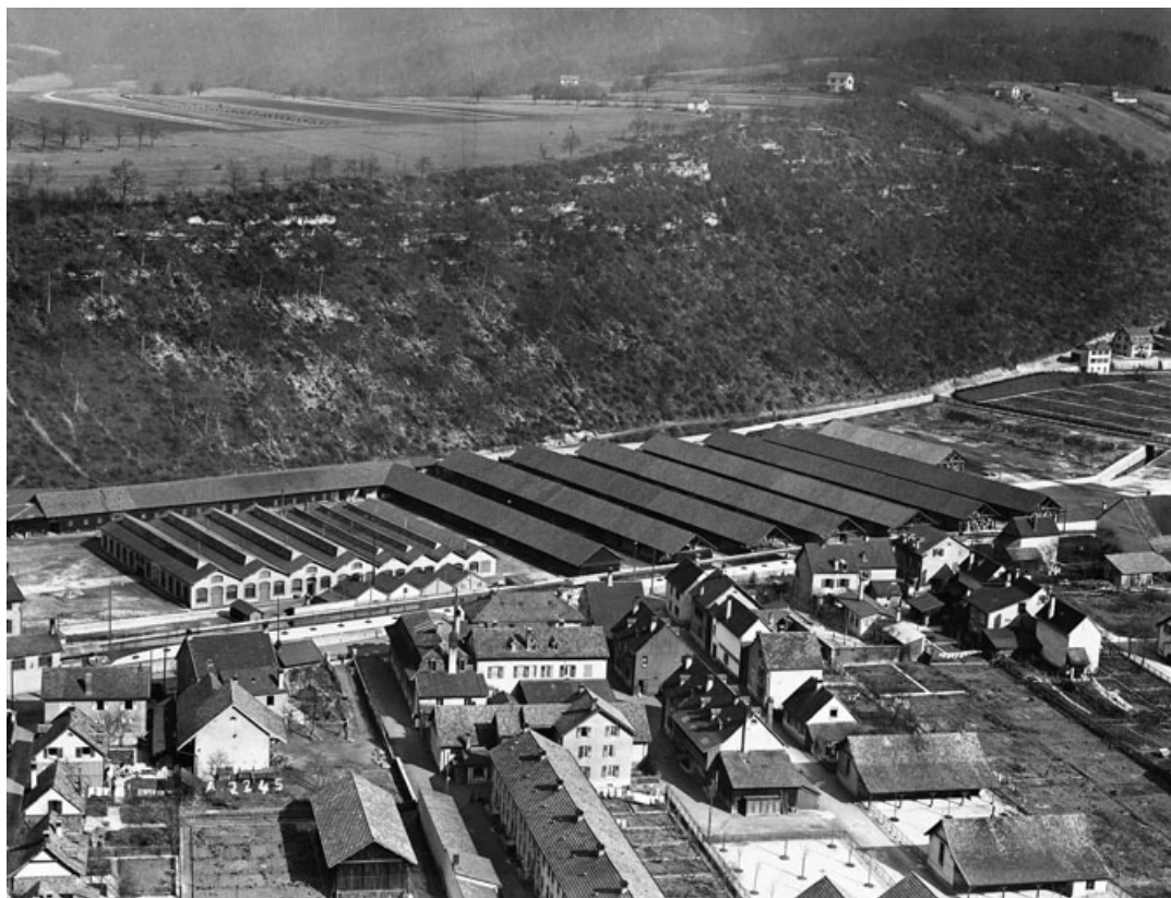
Extrémité sud de l'usine.
