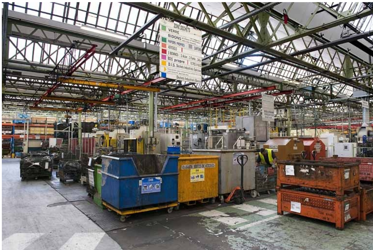
Atelier de rénovation boîtes de vitesses. Vue d'ensemble.
