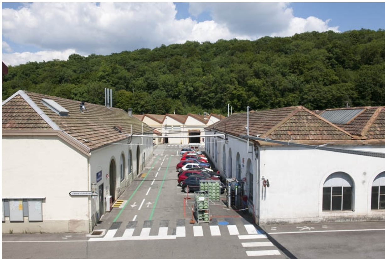
Magasin industriel et atelier de maintenance. 25, Hérimoncourt, 34 rue du Commandant Rolland
