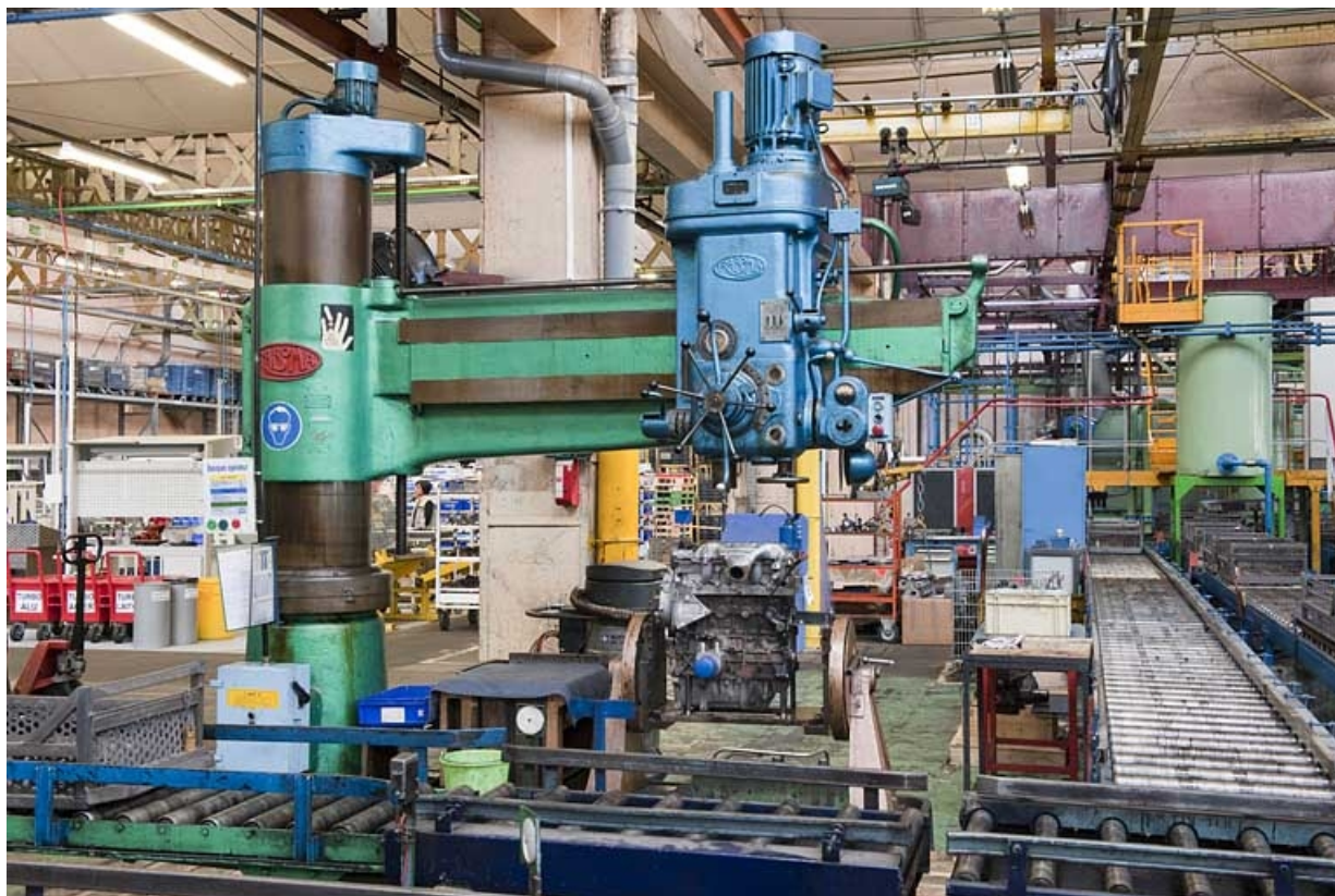
Atelier de rénovation des moteurs. Perceuse Rabora.
