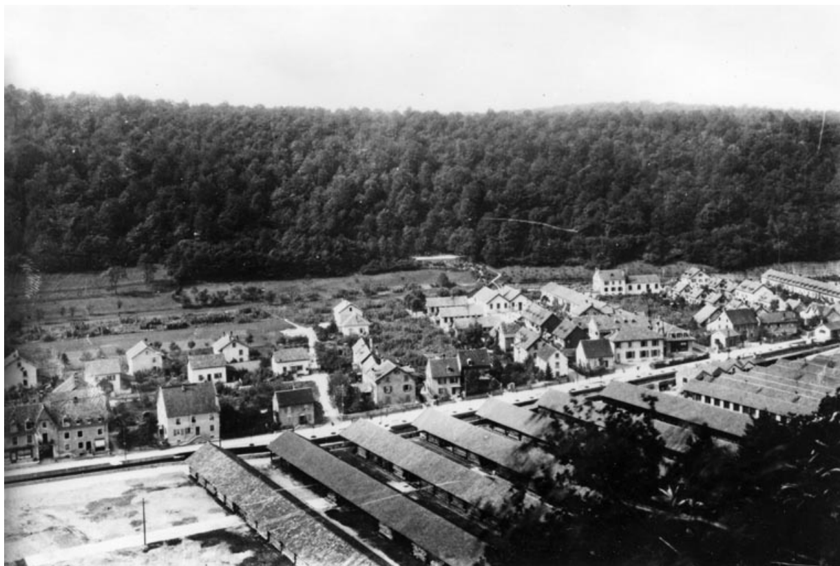
Entrepôts industriels au sud de l'usine et cité ouvrière.
