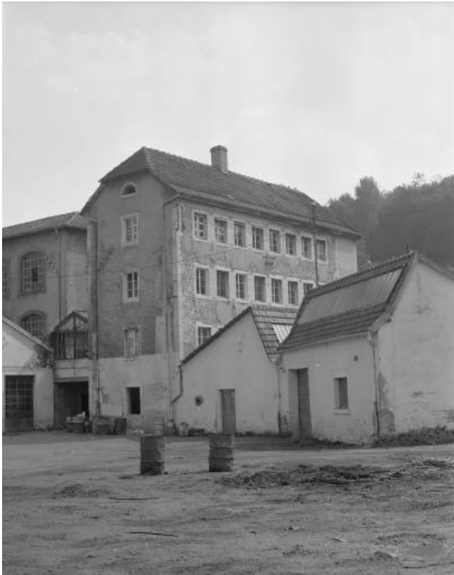
Élévation d'un ancien atelier en 1981.
