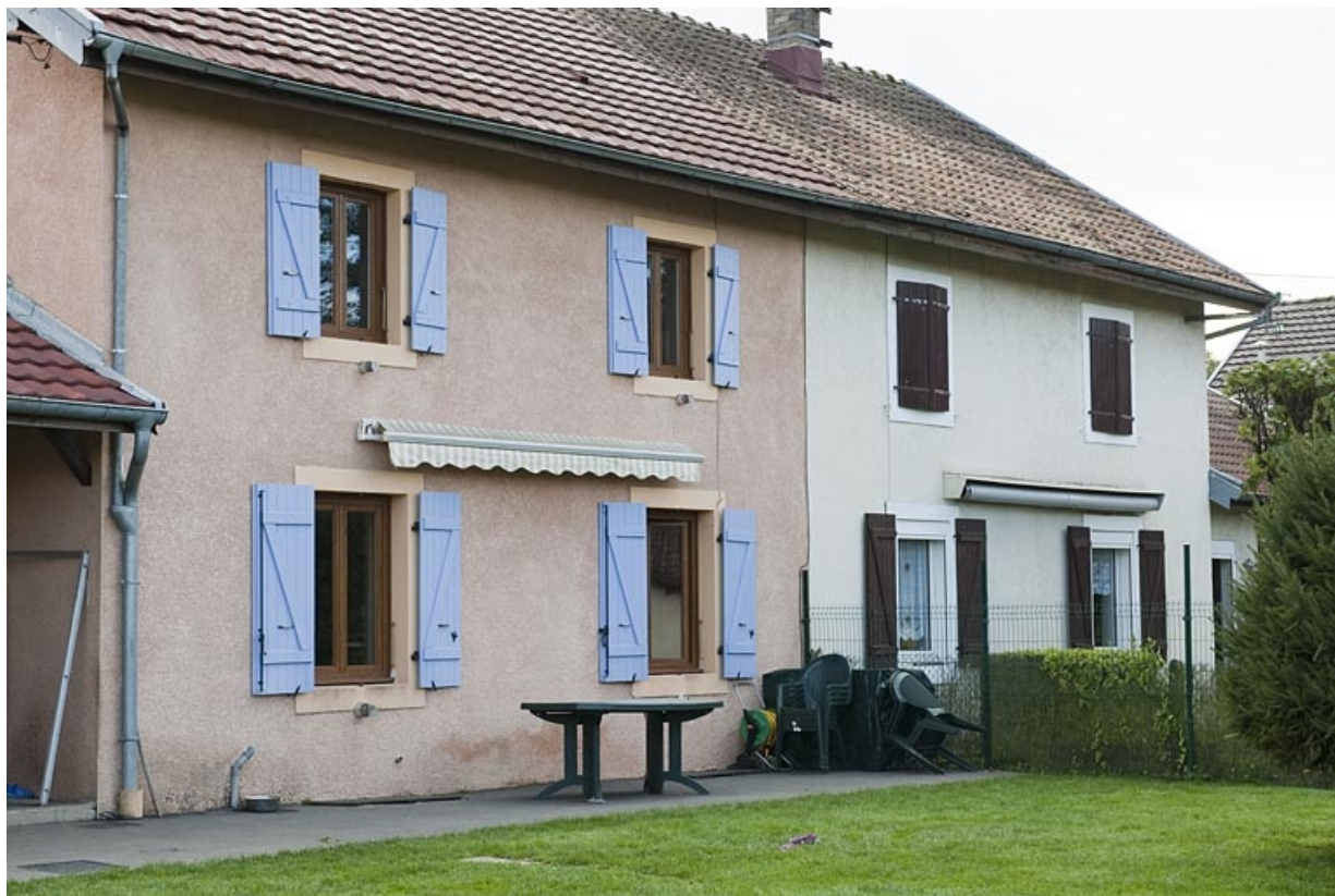
Habitation de 4 logements. Détail de la façade ouest.
