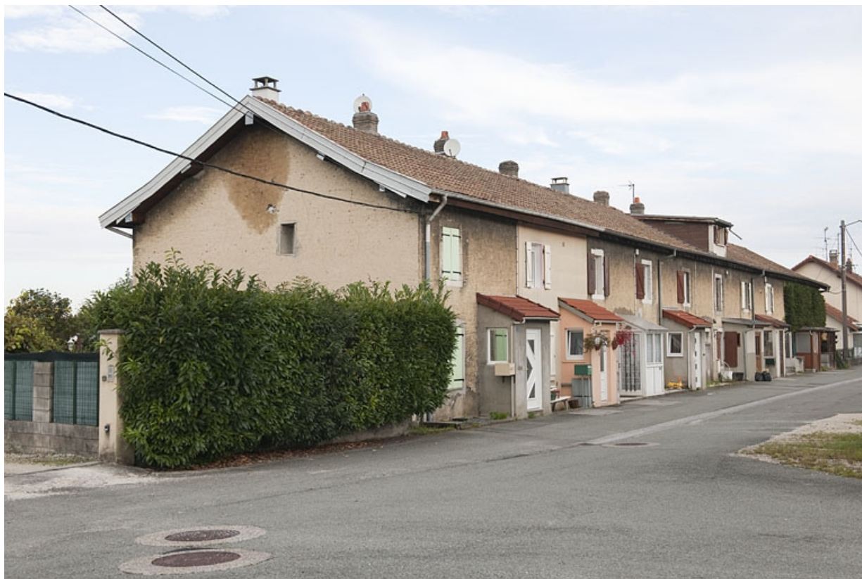
Habitation de 10 logements. Vue d'ensemble depuis le sud-est.
