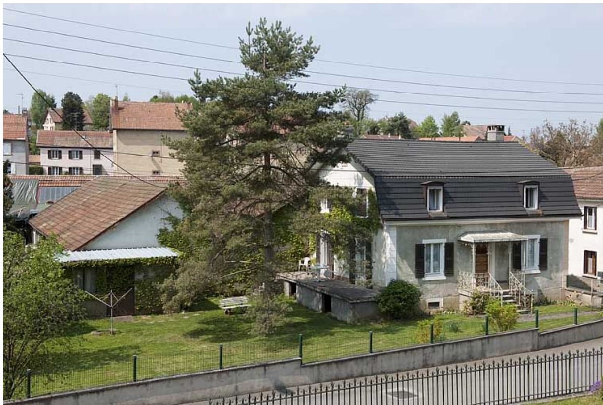
Vue d'ensemble depuis la rue des Combes.
