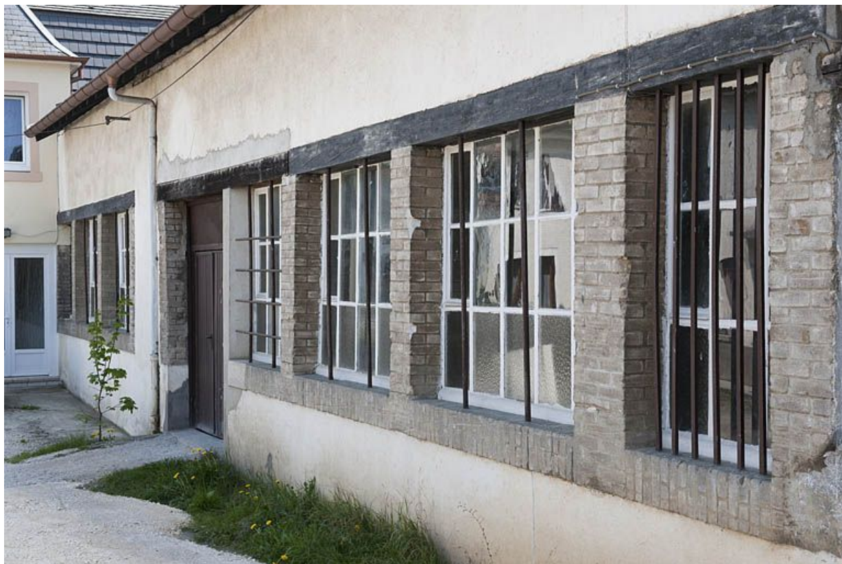
Mur nord de l'atelier de fabrication.
