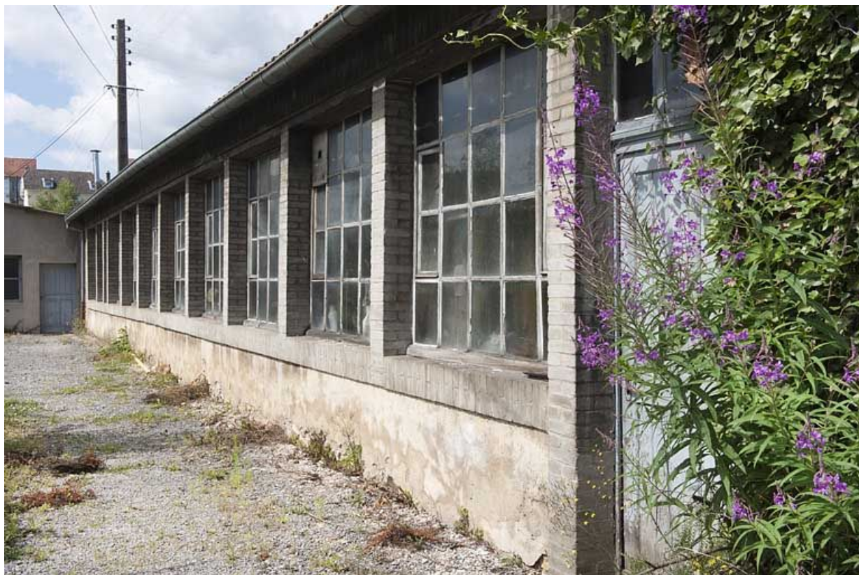
Façade est de l'atelier de décolletage primitif.
