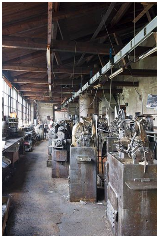
Atelier de décolletage primitif. Vue axiale. 25, Seloncourt, 79, 81 rue du Général Leclerc
