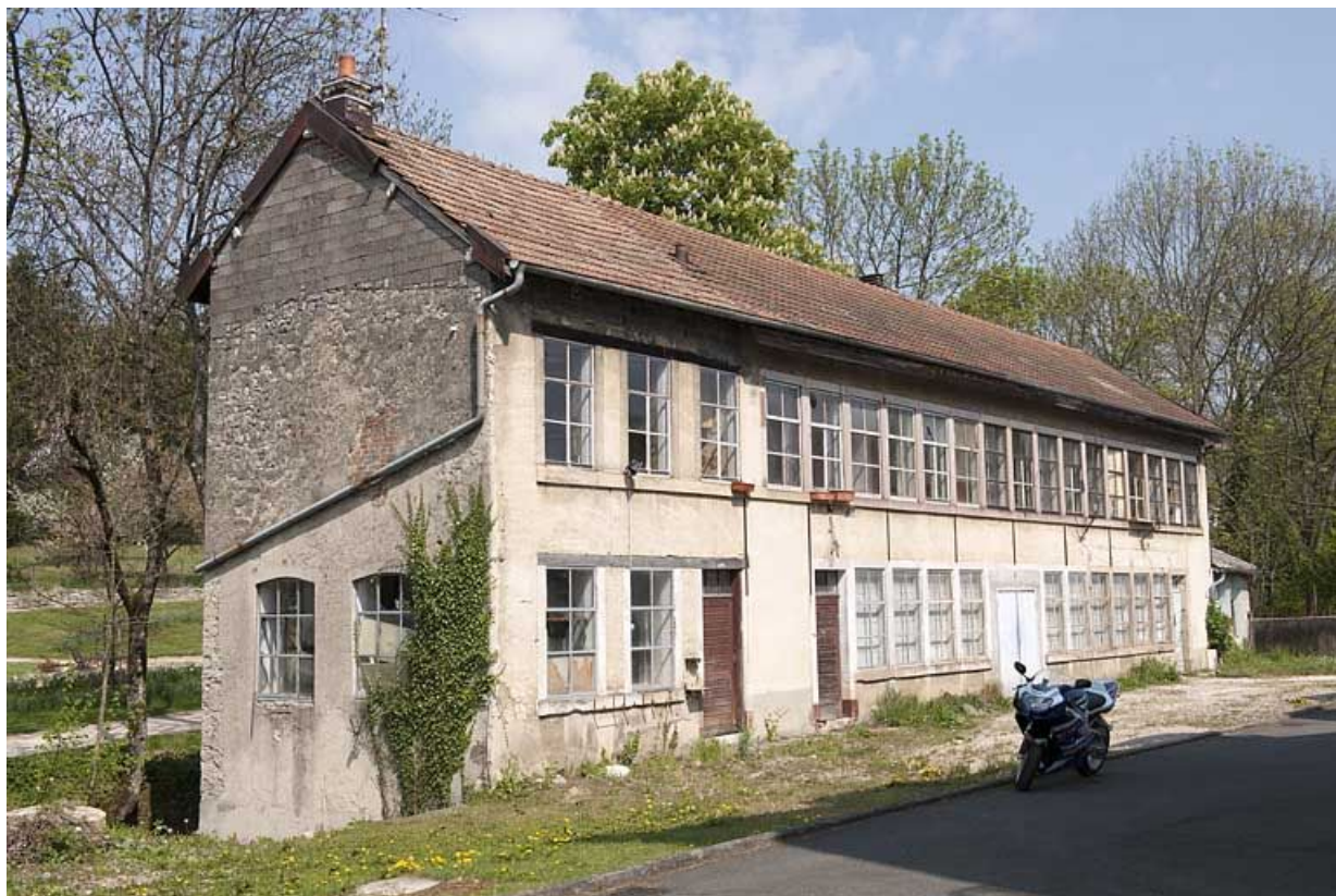
Atelier de fabrication vu de trois quarts gauche.
