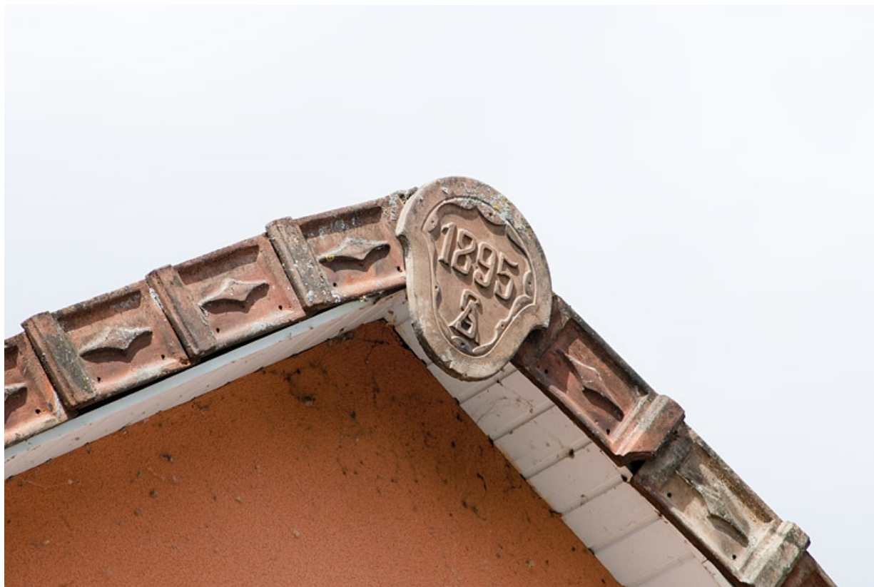
Faîte du toit du pignon nord. Antéfixe daté 1895.
