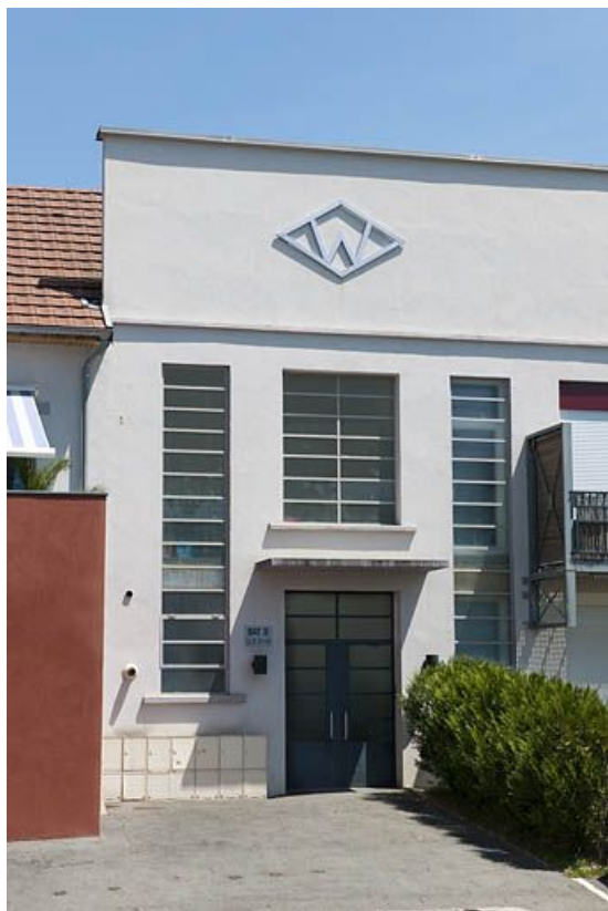
Détail de la façade occidentale.
