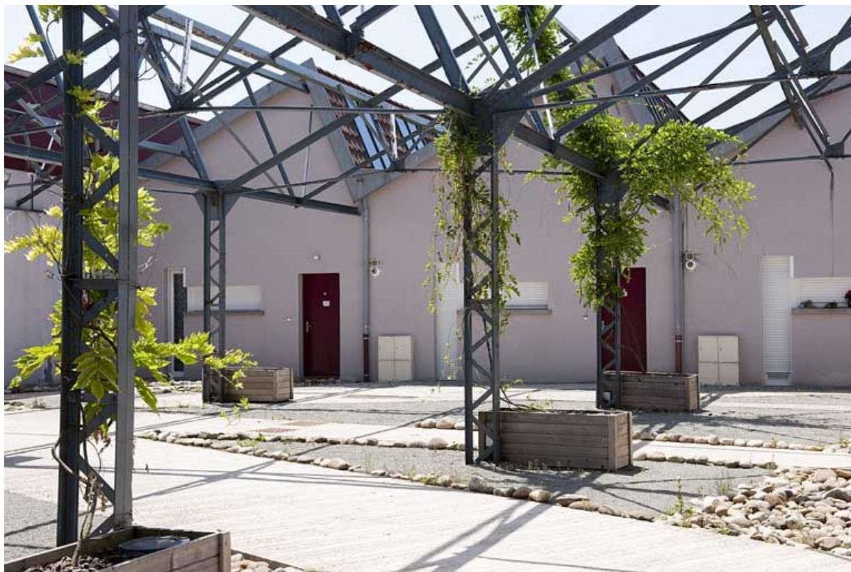
Réhabilitation d'un bâtiment industriel. Vue rapprochée depuis le sud.
