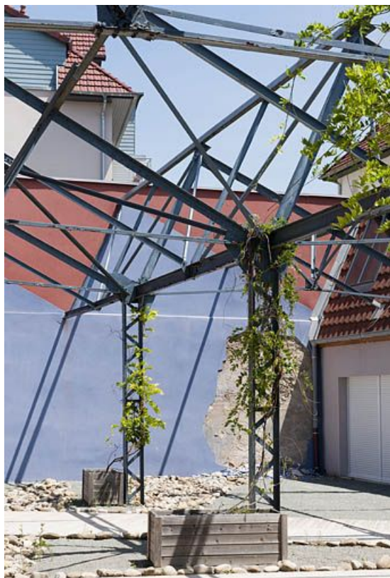
Réhabilitation d'un bâtiment industriel. Détail de la charpente métallique.
