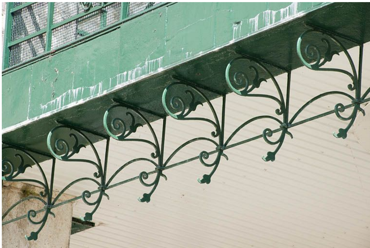
Passerelle sur la façade postérieure. Eléments de décor en fer forgé. 25, Seloncourt, 20 rue de la Côte
