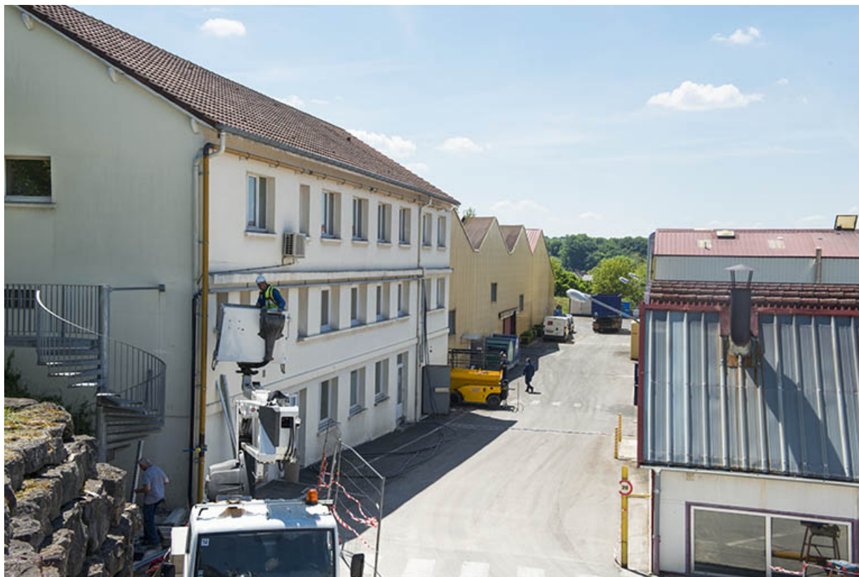
Bâtiment administratif et atelier de fabrication.
