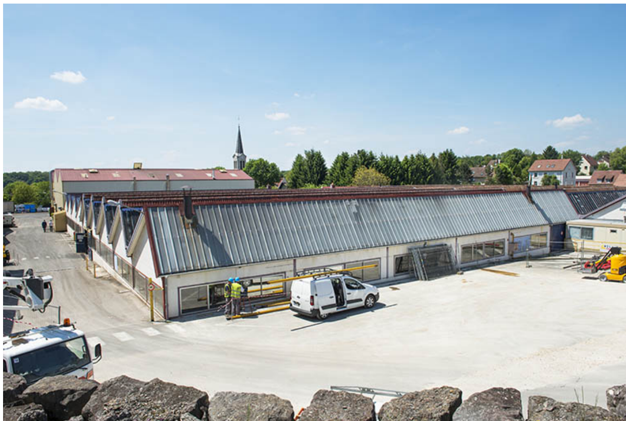
Atelier de fabrication. Vue plongeante depuis le sud-est. 25, Dasle, 1 rue Centrale
