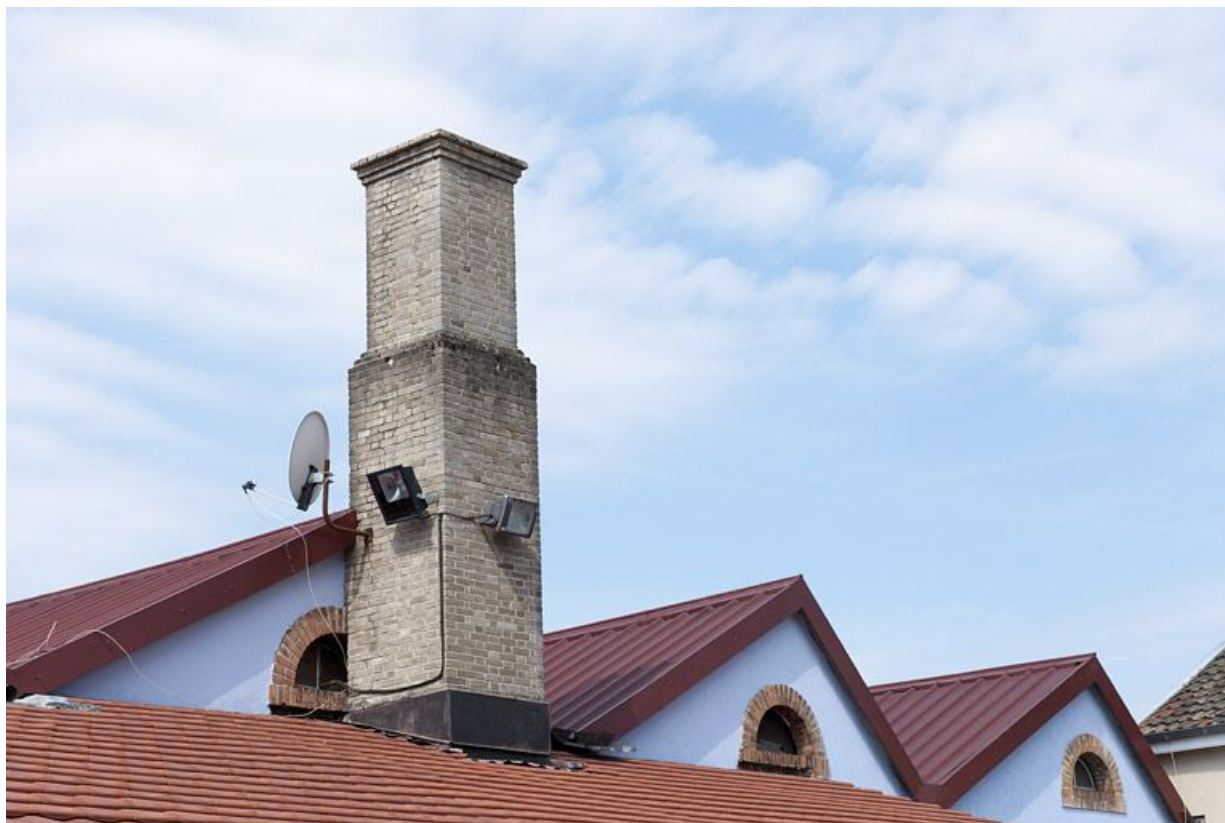
Détail de la cheminée de l'ancienne chaufferie.
