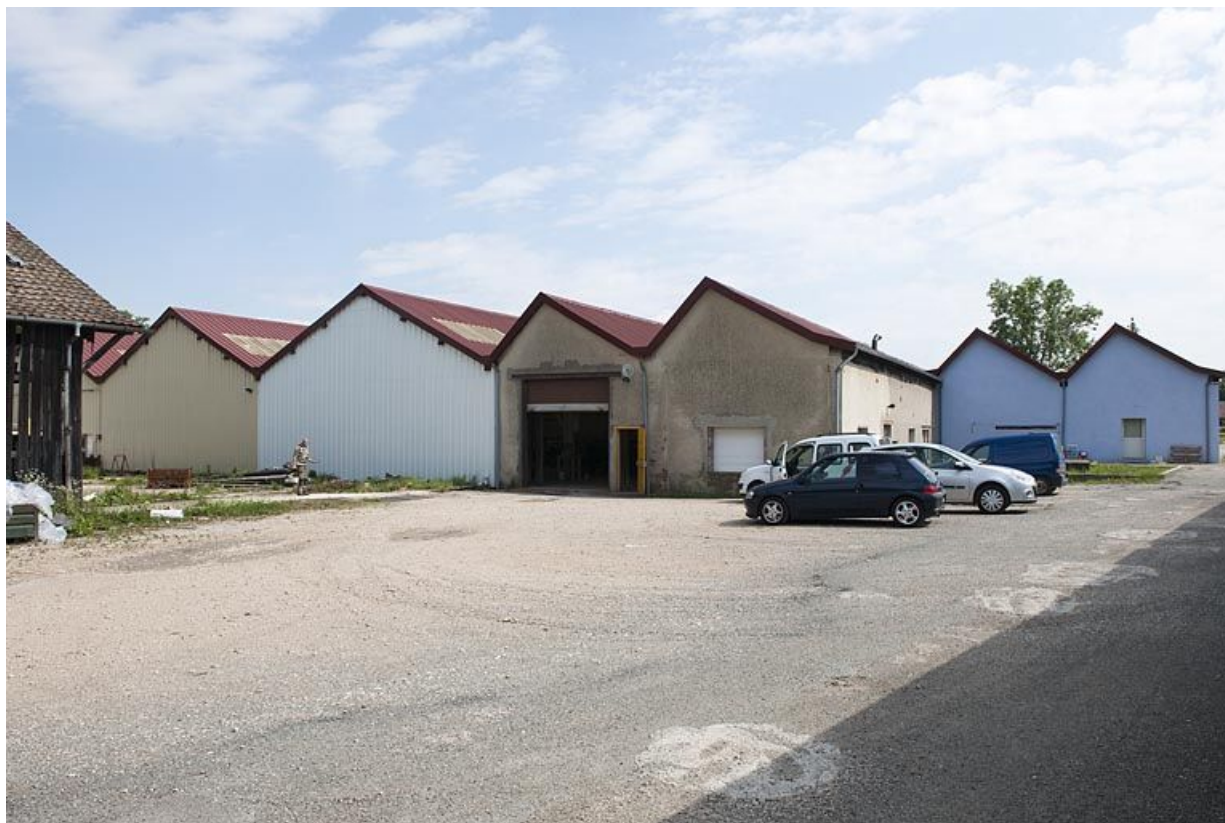
Pignons sud de l'atelier de fabrication.
