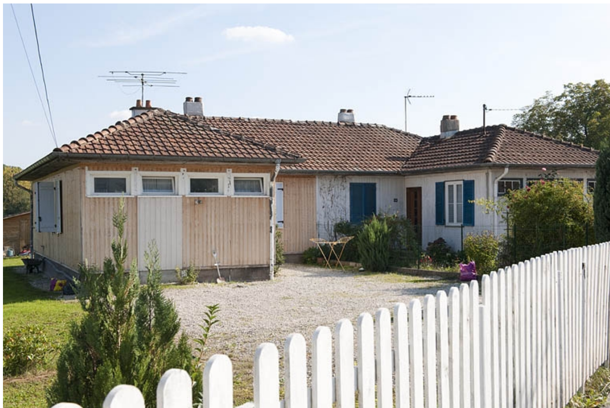
Maison jumelée située aux n°12-14.
