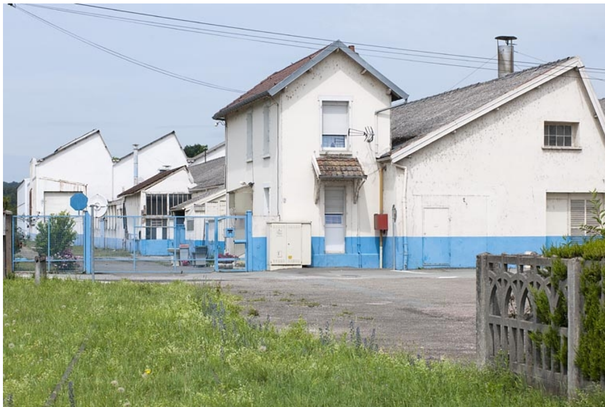
Bâtiments sud et conciergerie depuis le sud-est.
