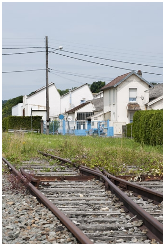
Bâtiments sud et conciergerie depuis la voie ferrée de l'usine.
