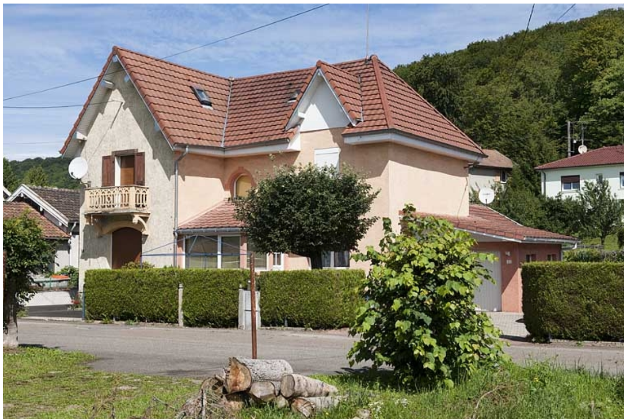
Maison de contremaîtres (n°12-14). 25, Bavans, 1 à 19 rue de l' Emaillerie
