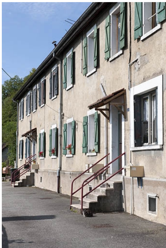
Habitation à 8 logements. Détail de la façade antérieure. 25, Bart rue du Mont-Bart
