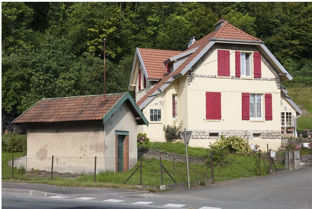
Maison jumelée. Façade antérieure.
