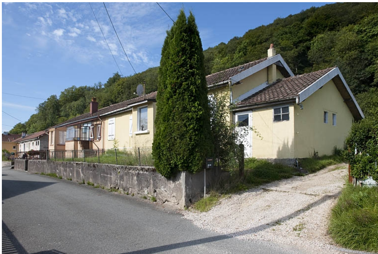
Habitation ouvrière en rez-de-chaussée. Vue d'ensemble depuis l'est. 25, Bart rue du Mont-Bart
