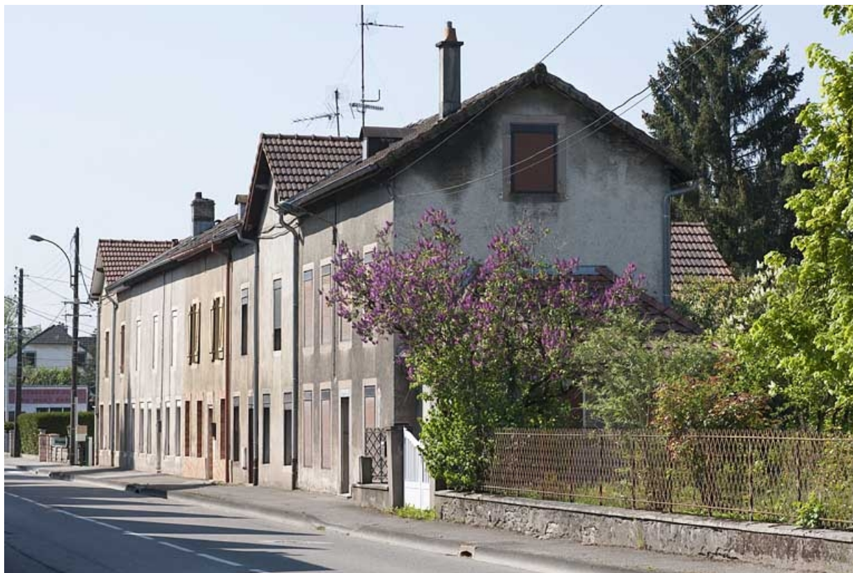
Logements ouvriers. Vue de trois quarts droite. 25, Bart rue de la Gare, lieudit : ZA des Andanges
