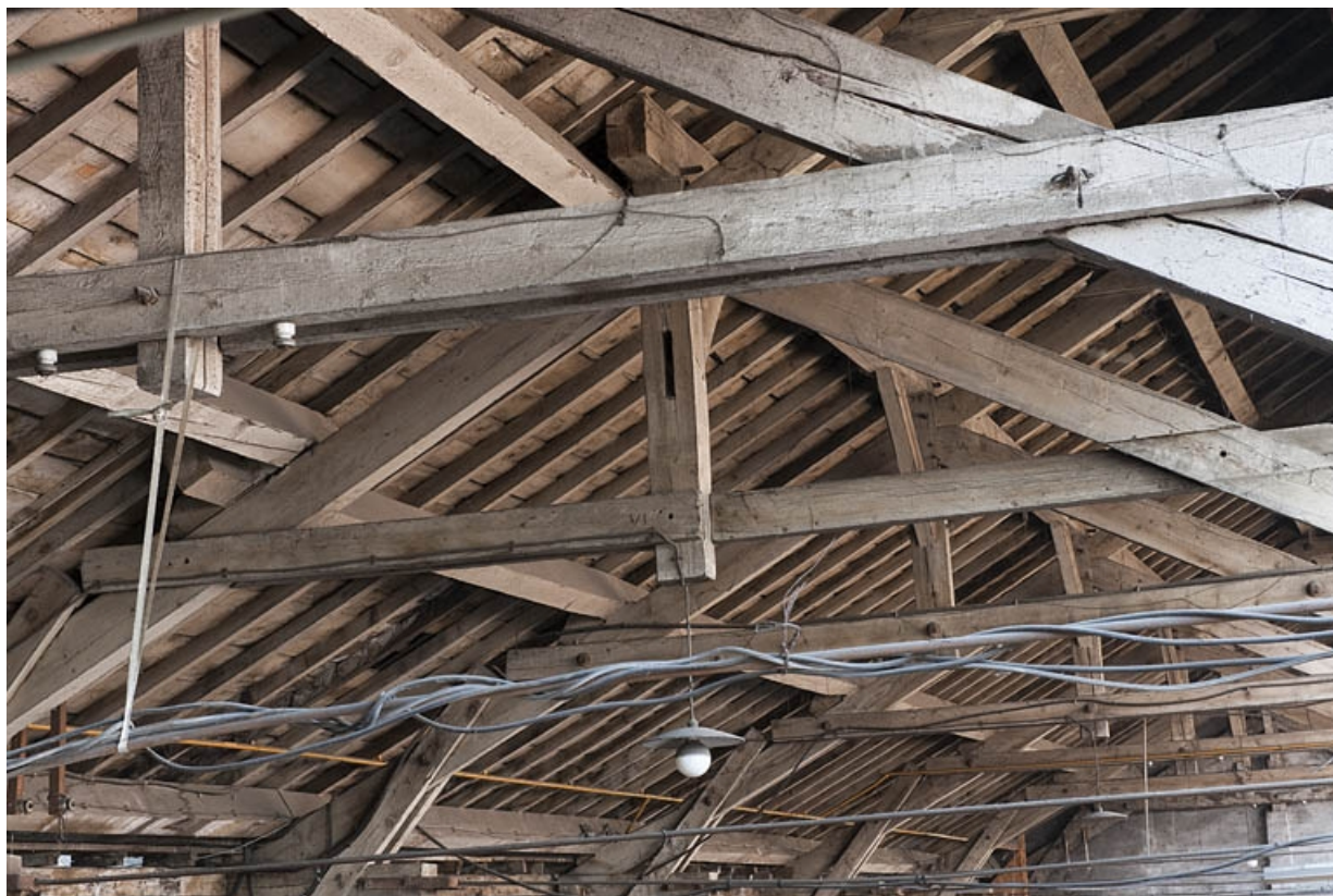
Détail de la charpente du magasin industriel. 25, Bart rue de la Gare, lieudit : ZA des Andanges
