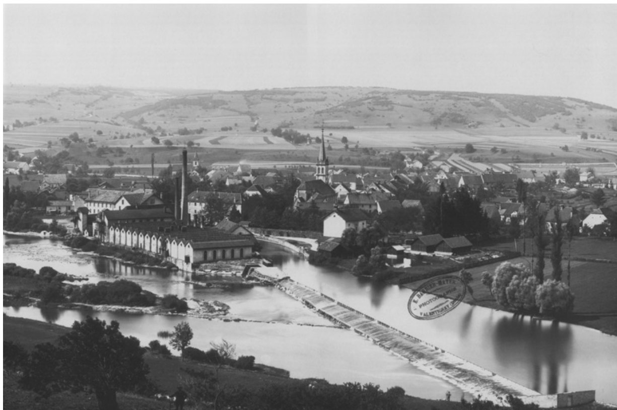
Le village de Mandeure depuis la rive gauche du Doubs.
