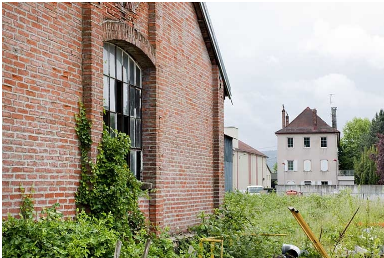
Pignons de l'entrepôt industriel et du bâtiment administratif.
