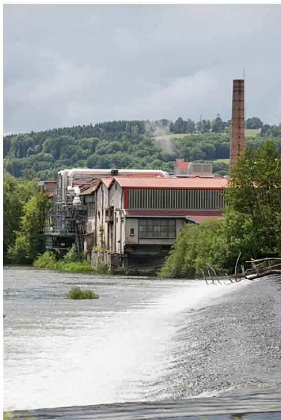
Barrage et bâtiments industriels depuis le nord.
