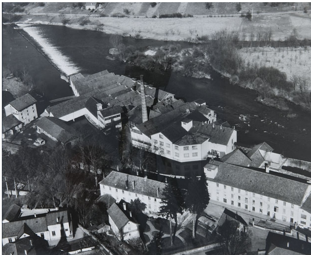
Vue aérienne depuis le sud-ouest.
