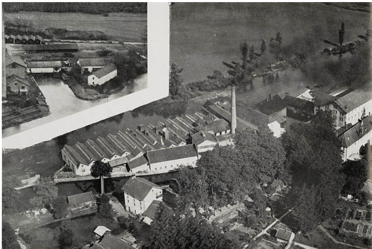
Les papeteries de Mandeure (Doubs). 25, Mandeure, 14 rue de la Papeterie
