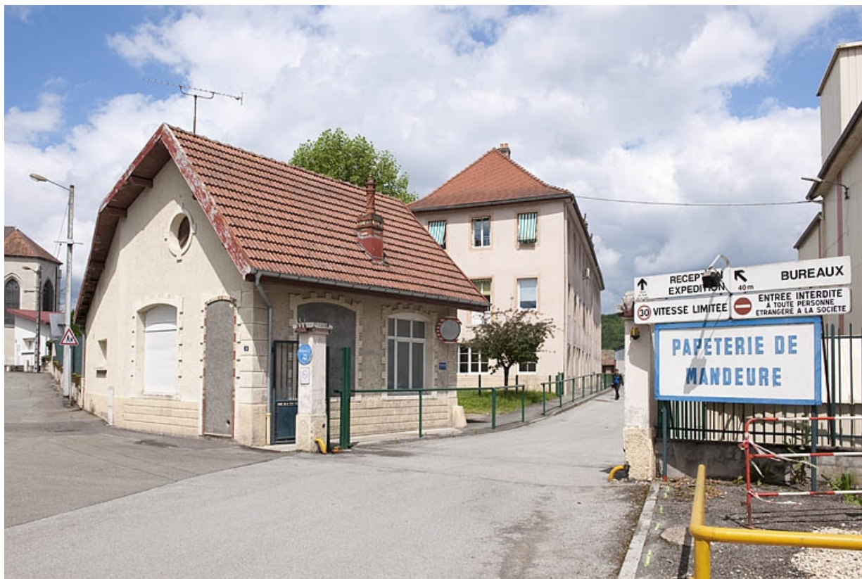
Conciergerie et bâtiment administratif à l'entrée du site.
