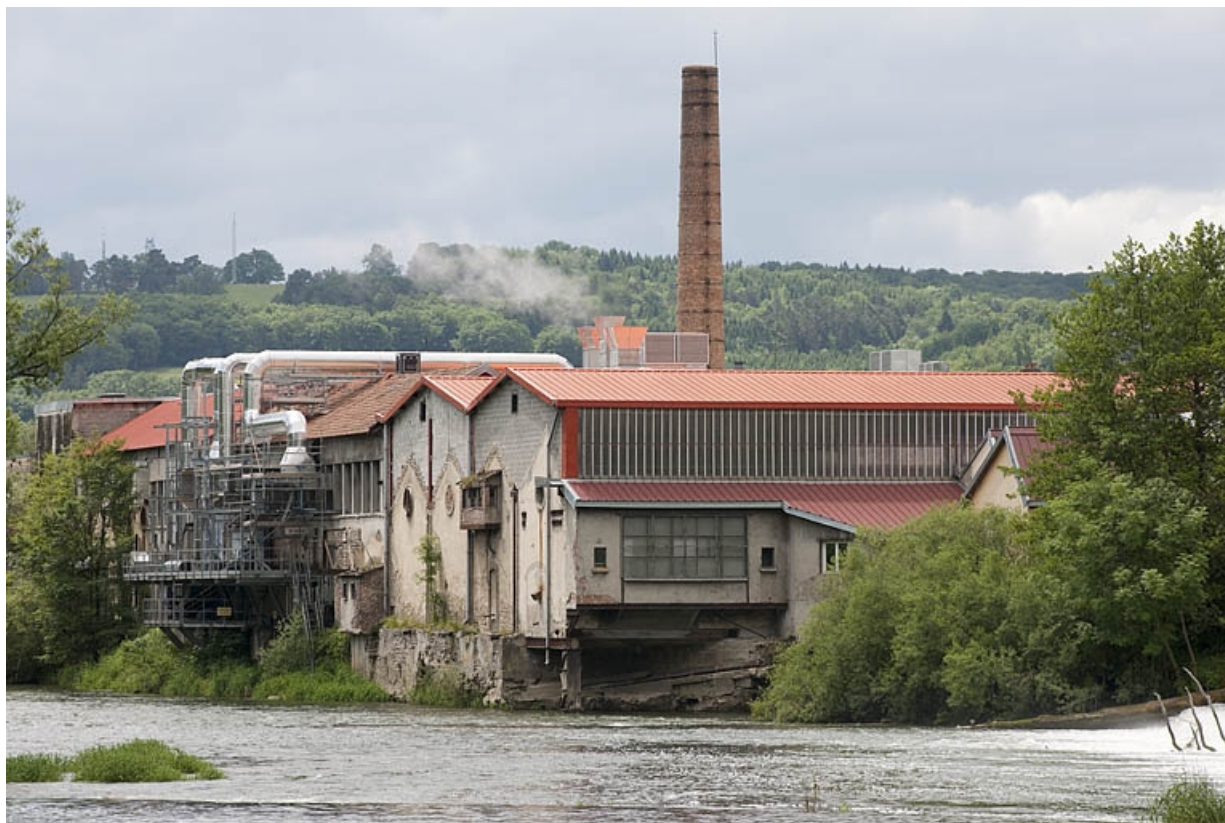
Bâtiments industriels depuis le nord.
