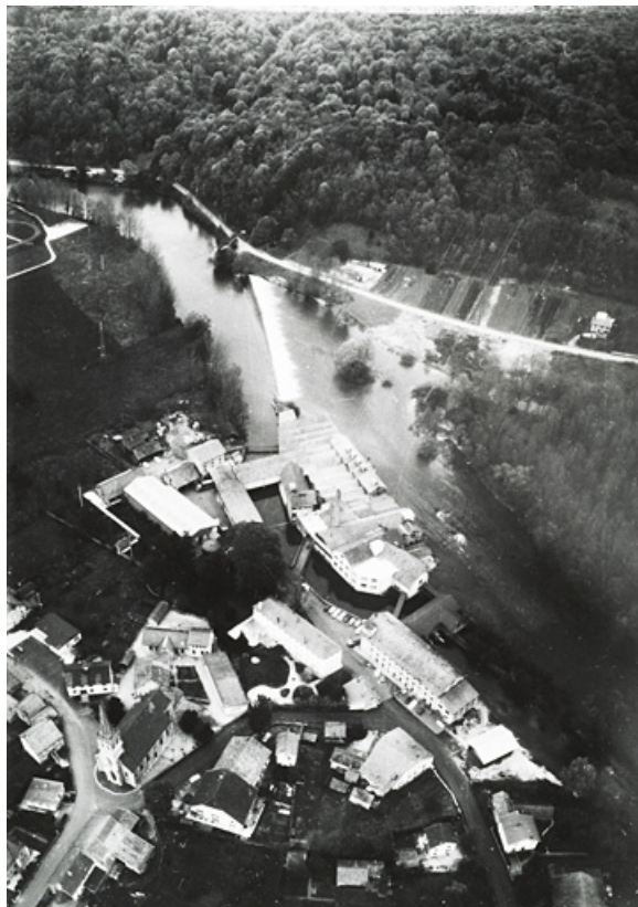
Vue aérienne depuis le sud-ouest. 25, Mandeure, 14 rue de la Papeterie
