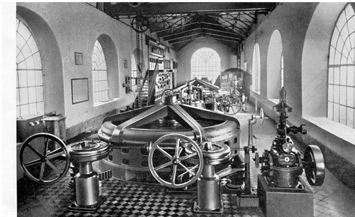
USINE DE BELCHAMP : Salle des machines comprenant 2 groupes à axe vertical de 350 CV chacun.
