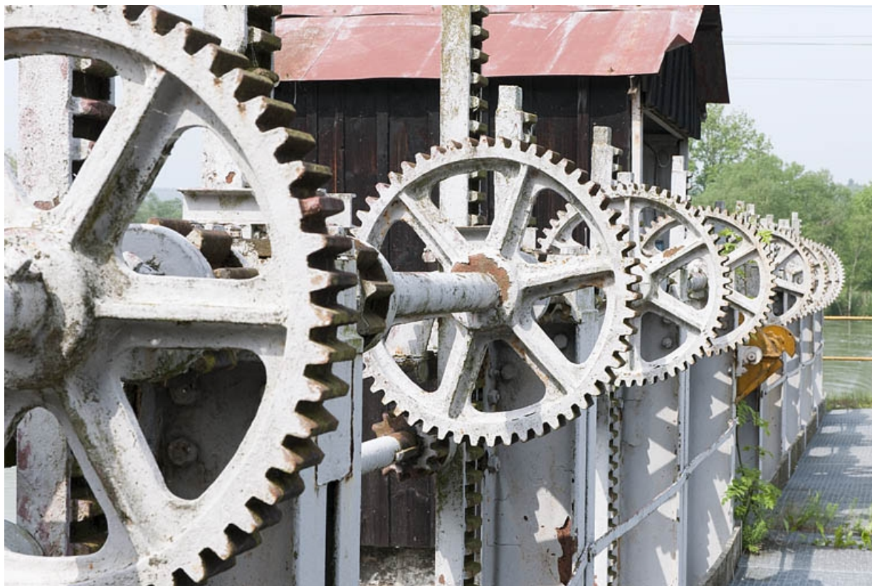
Vannage du barrage. Détail des engrenages.
