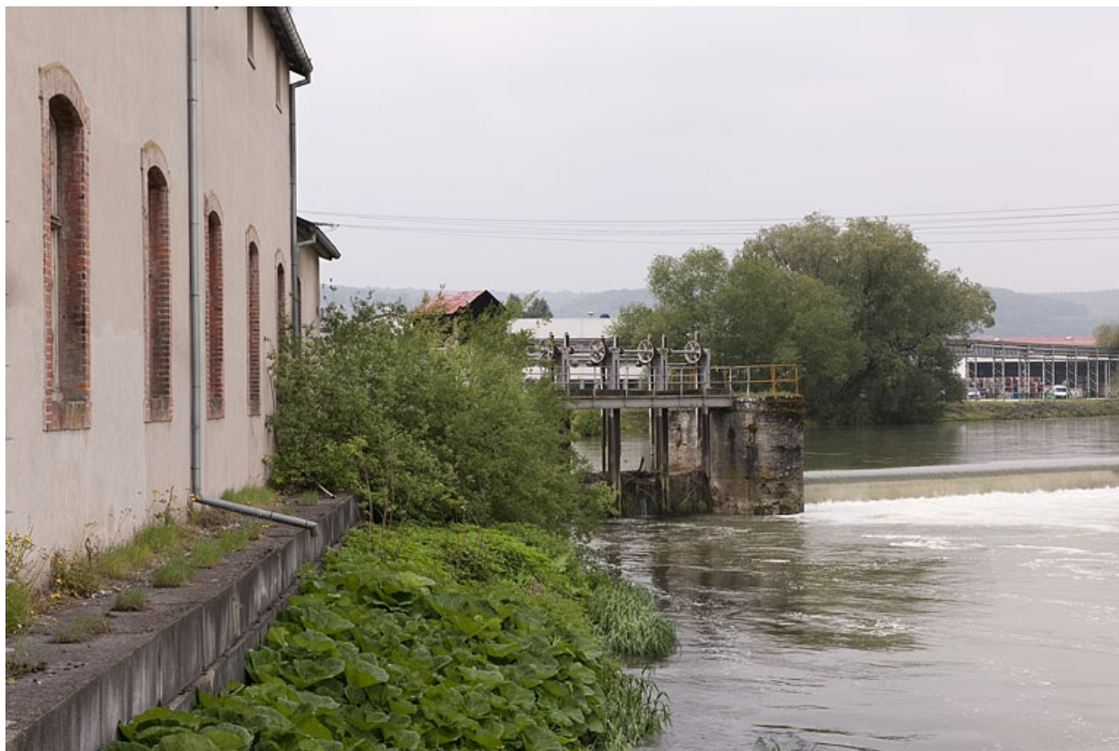
Façade nord du bâtiment industriel et vannage du barrage.
